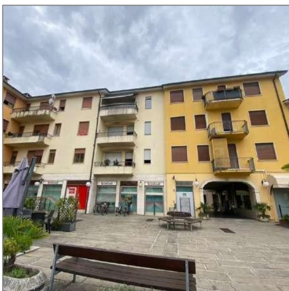
Il fronte Nord e l'accesso al piano interrato
