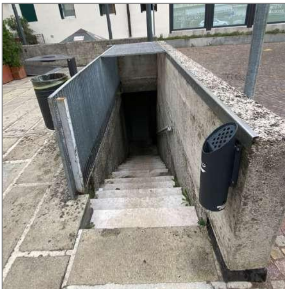
FOTO 19 - Accesso pedonale all'interrato
