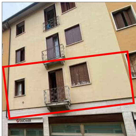
FOTO 2 - L'appartamento al piano primo
