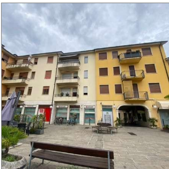
FOTO 5 - Il fronte Nord e l'accesso al piano interrato
