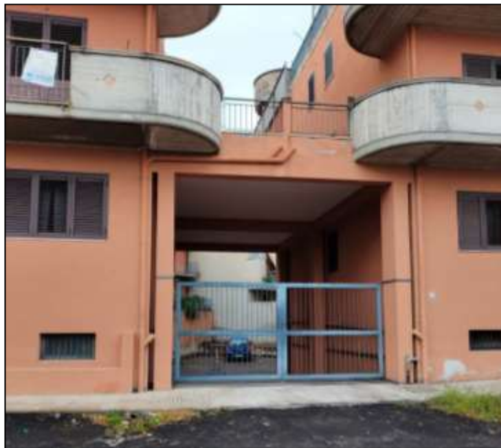
Figura 6 - Vista accesso carrabile al cortile interno condominiale del fabbricato in cui sono ubicati n. 3 posti auto scoperti (NCEU - Foglio24 part1199 sub.62,63,64).
