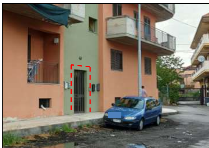
Figura 5 - Vista accesso, dalla traversa di Via Mazzaglia, al vano scala del Corpo A che porta alla cantina ubicata al piano S1 (NCEU Foglio 24 part 1199 sub.47).
