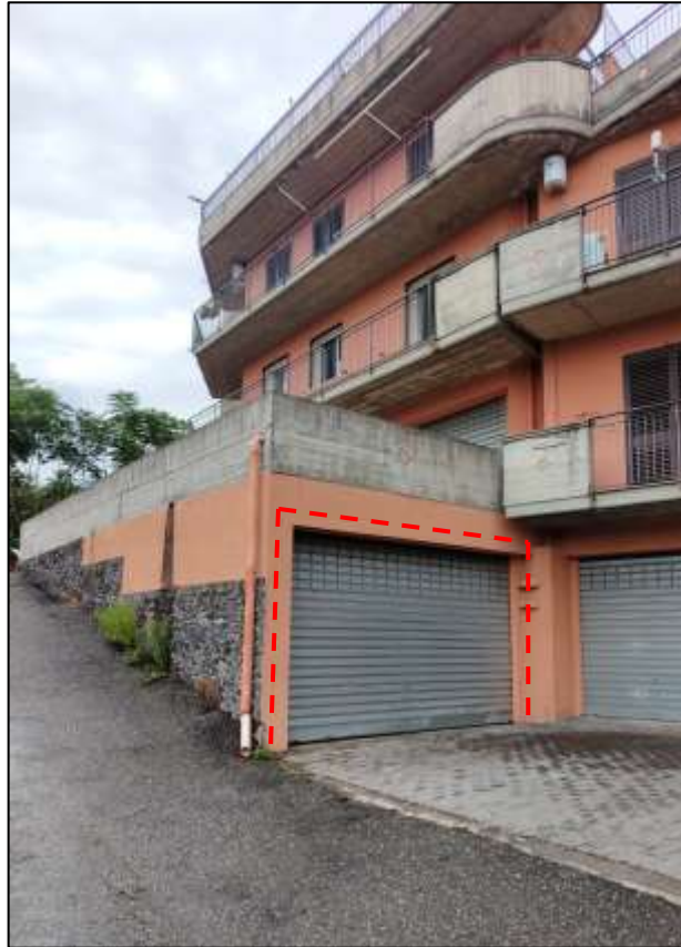
Figura 24 - Vista accesso carrabile al garage (NCEU Foglio 24 part 1199 sub.67) dalla traversa di Via Mazzaglia.
