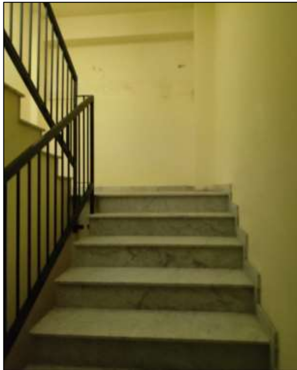
Figura 25 - Vista accesso pedonale al garage dalla scala condominiale del Corpo C.
