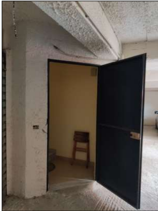
Figura 26 - Vista portone di accesso alla corsia garage dal vano scala condominiale del Corpo C.
