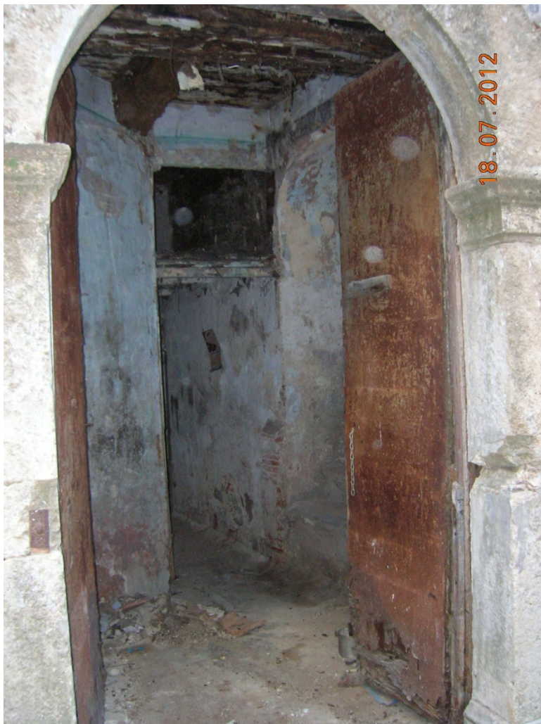
FOTO N. 11 INTERNO LOCALE A PIANO TERRA VICO IV° SANTA LUCIA
