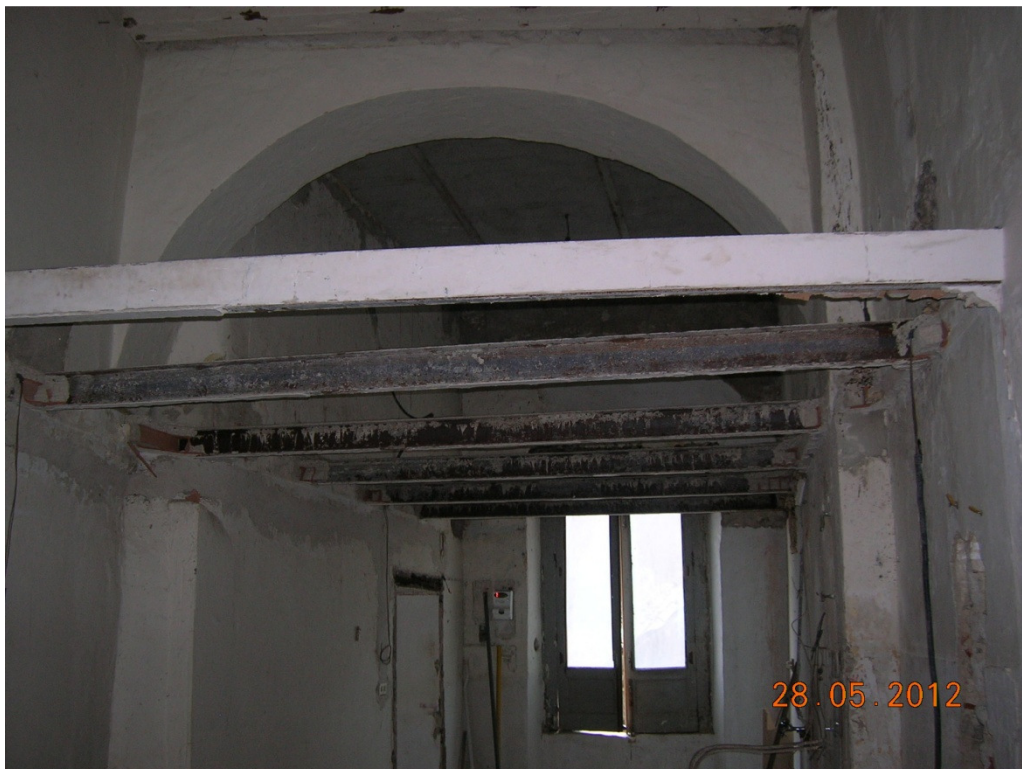
FOTO N. 08 STRUTTURA DEL SOLAIO
