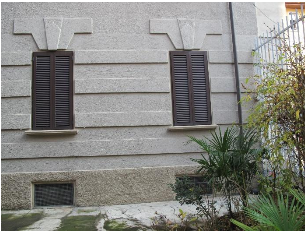
esterno appartamento verso cortile di altro Condominio via De Predis 4
