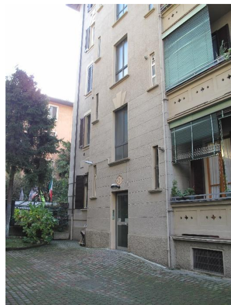
esterno fabbricato – ingresso scala "D"
