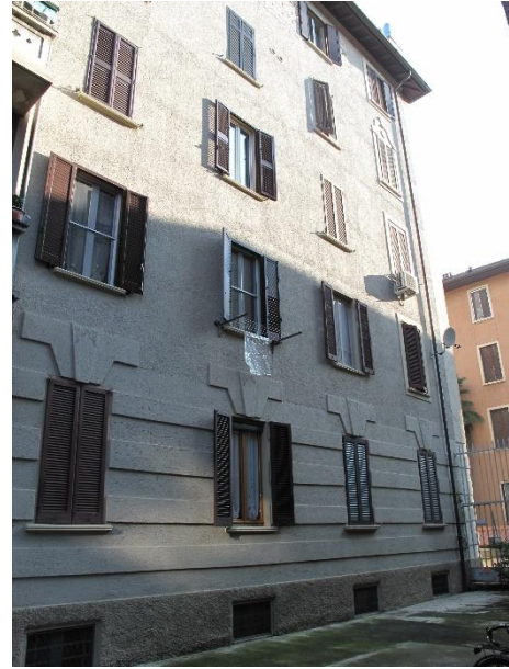
esterno fabbricato – scala "D" verso cortile di altro Condominio via De Predis 4
