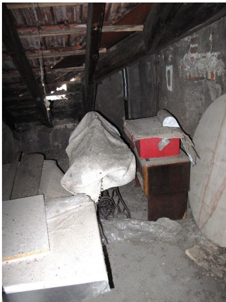
interno solaio sottotetto
