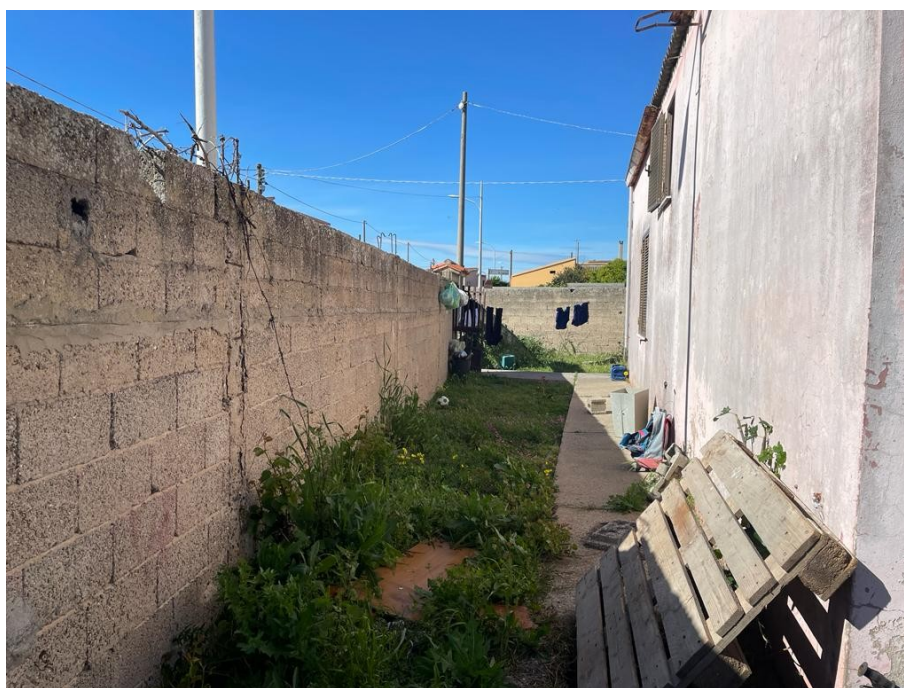
Foto 22_ Vista cortile interno
