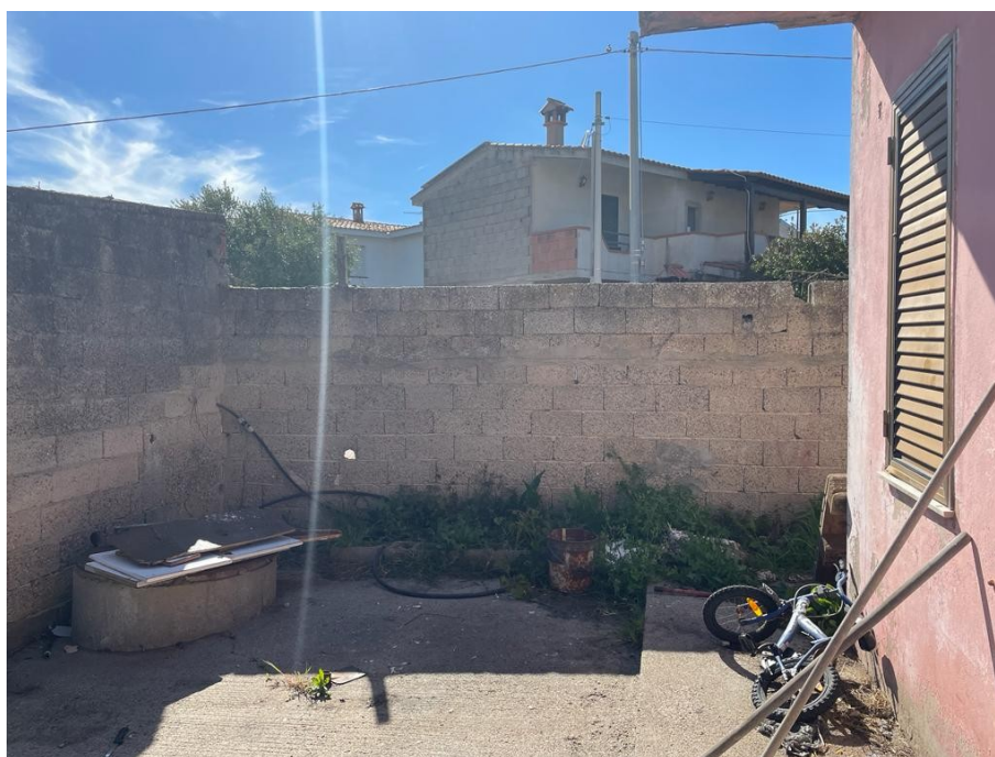
Foto 20_ Vista cortile interno
