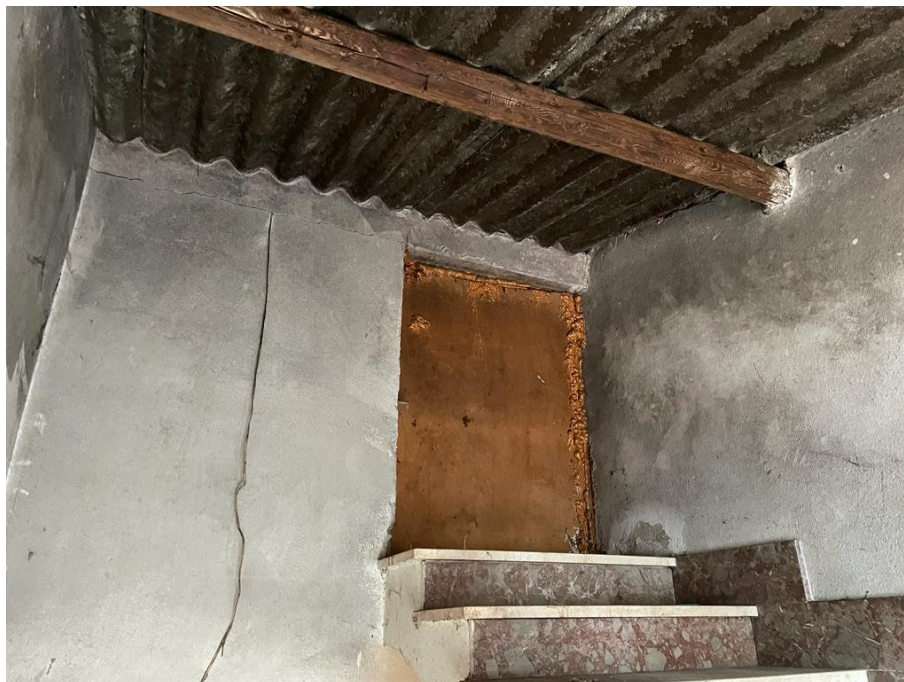
Foto 19_ Vista accesso al locale sottotetto non accessibile
