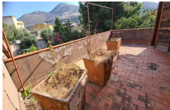
Foto n. 65 Vano letto - Terrazzo a livello
