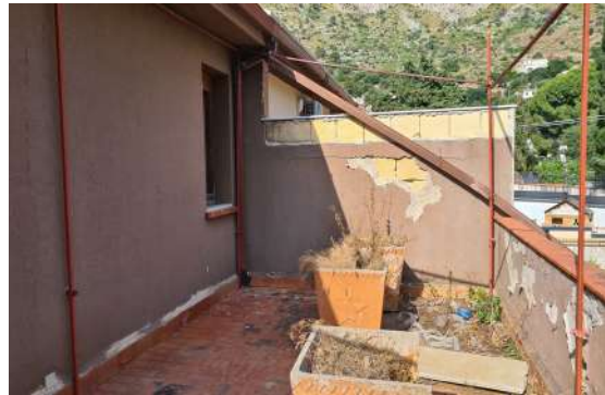
Foto n. 63 Vano letto – Terrazzo a livello
