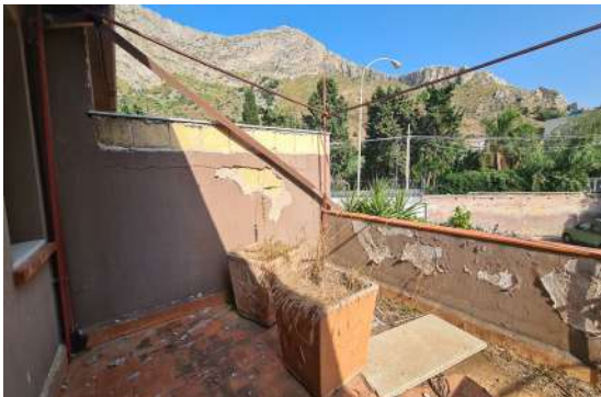
Foto n. 64 Vano letto - Terrazzo a livello
