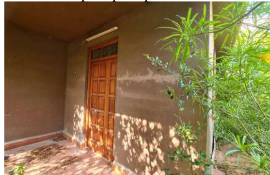
Foto n. 10 Prospetto principale-portoncino d'ingresso all'unità immobiliare
