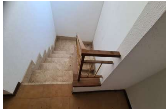
Foto n. 41 Vano scala - pianerottolo p. primo
