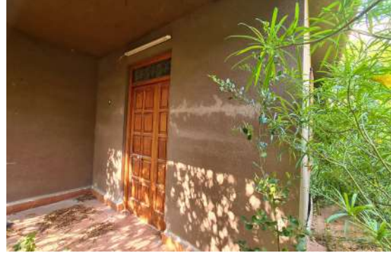
Foto n. 10 Prospetto principale-portoncino d'ingresso all'unità immobiliare
