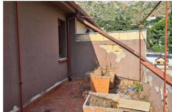
Foto n. 63 Vano letto – Terrazzo a livello
