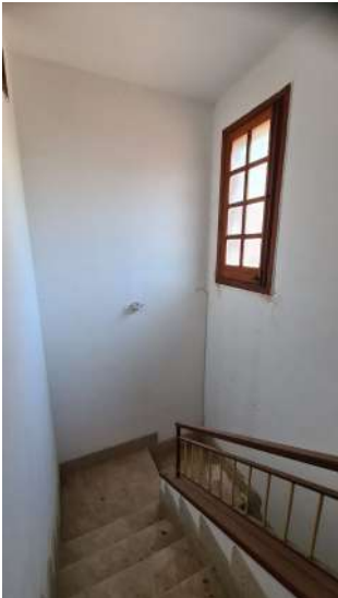
Foto n. 40 Vano scala - Infisso
