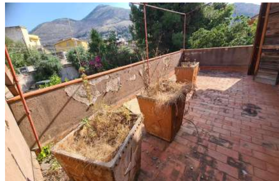
Foto n. 65 Vano letto - Terrazzo a livello
