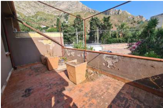
Foto n. 62 Vano letto – Terrazzo a livello
