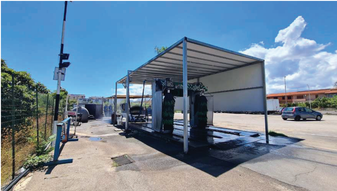
Foto n. 7 Interno – Zona autolavaggio
