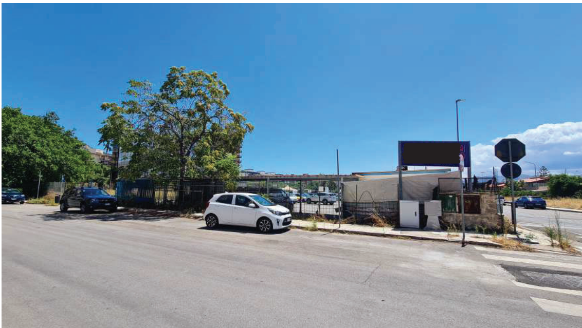
Foto n. 2 Esterno Area a parcheggio e autolavaggio
