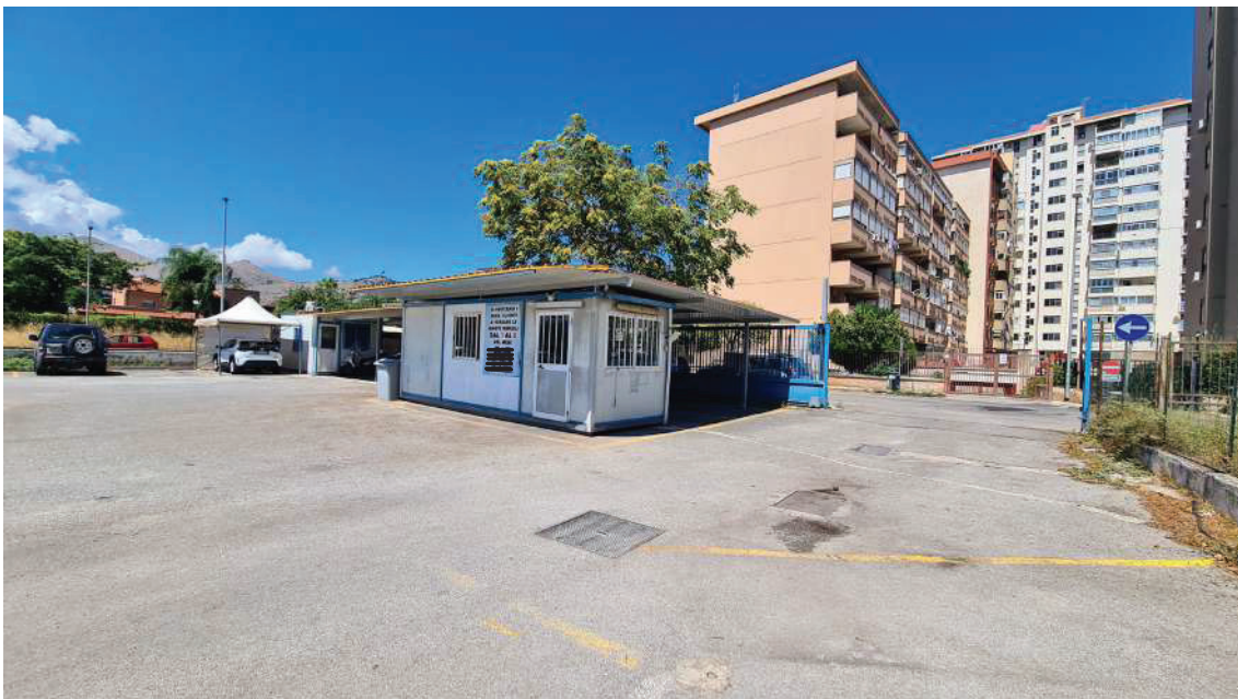
Foto n. 12 Interno – Cannello di accesso al parcheggio su Via Monte San Calogero
