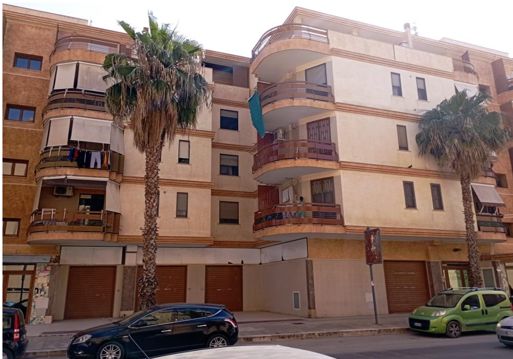
FOTO N. 2 - FABBRICATO VIA SUPERGA
