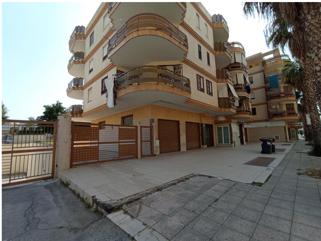
FOTO N. 12 - GARAGE CIV. 8 VIA SUPERGA
