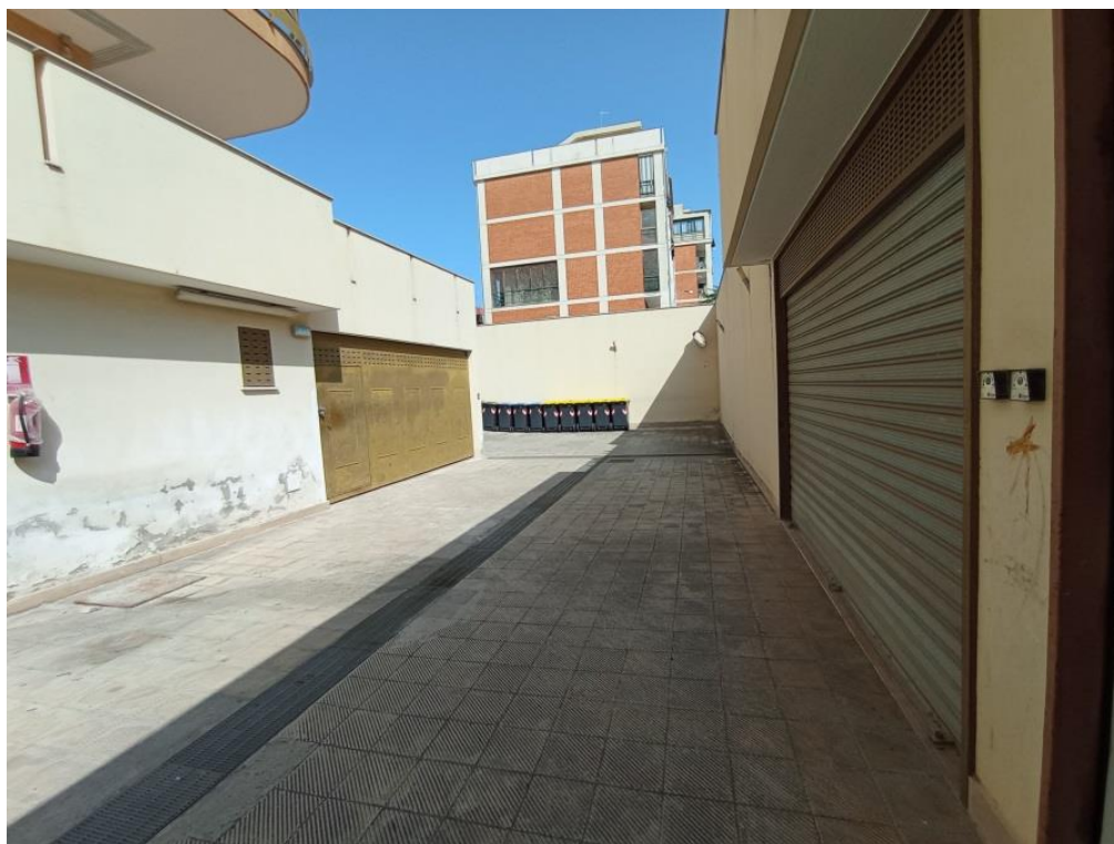
FOTO N. 15 CORSIA DI SCORRIMENTO
