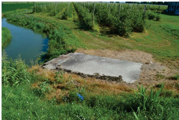
foto 3 - alla confluenza dello scolo ovest con l'emissario sinistro del Canal Bianco si trova una chiusa consortile. Il manufatto è collocato all'intersezione tra lo stradello costeggiante lo scolo e il terrapieno erboso che dà sullo spiazzo della chiesetta
