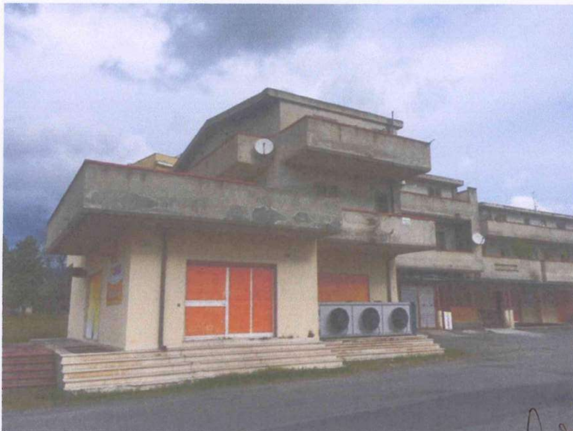
Foto 1 – Vista del fabbricato lato ingresso magazzini
