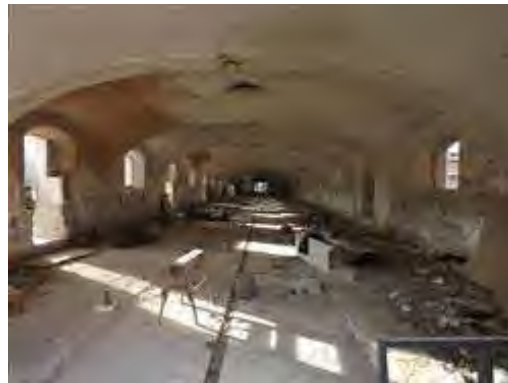
Fig.4 : Interno fabbricato E
