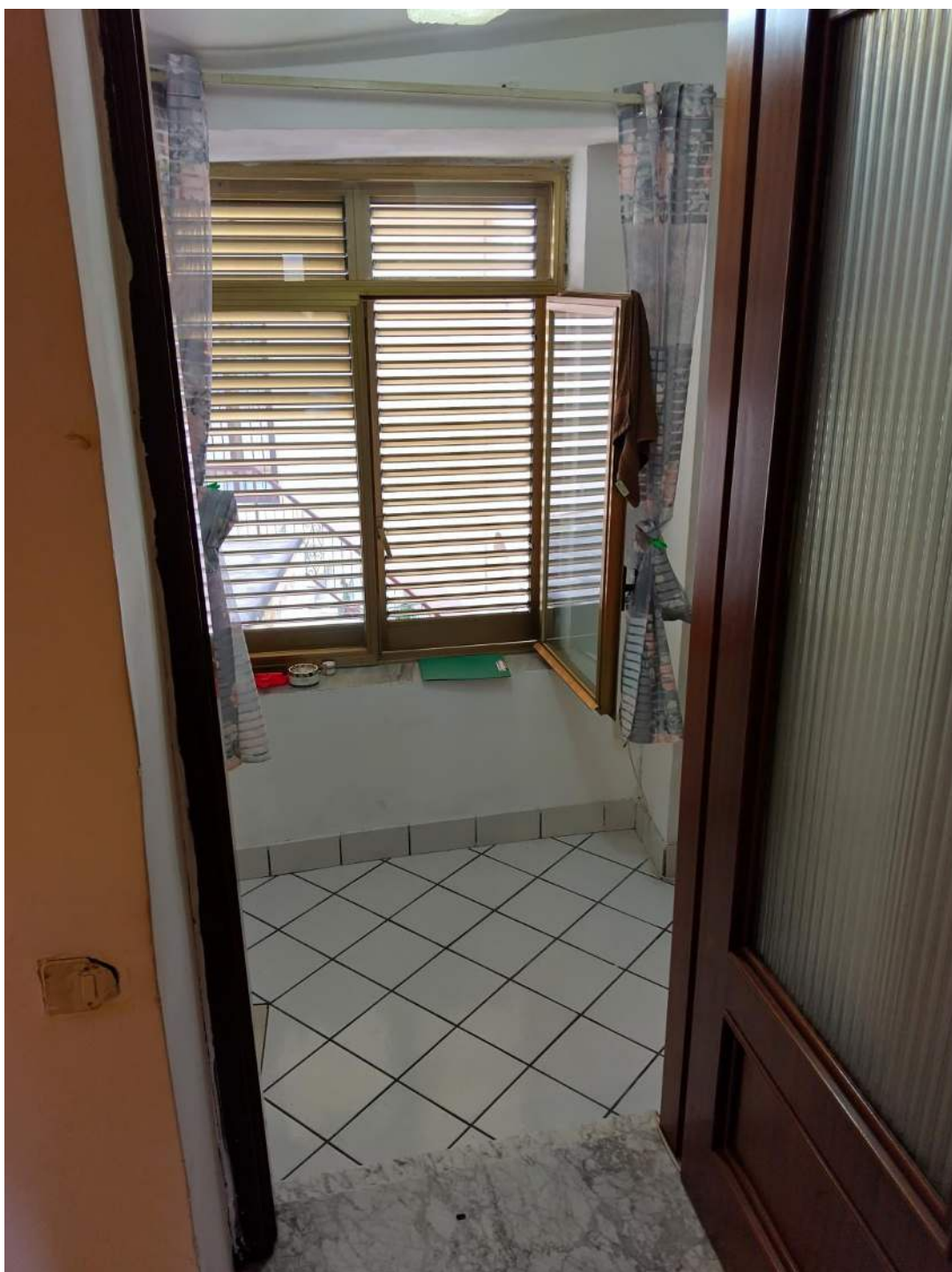
19 Vano scala esclusiva di accesso al piano primo
