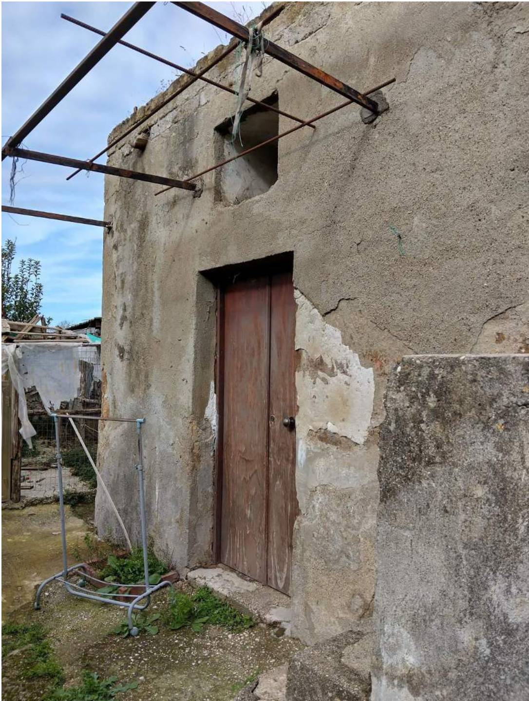
30 Porta d'ingresso vano piano terra
