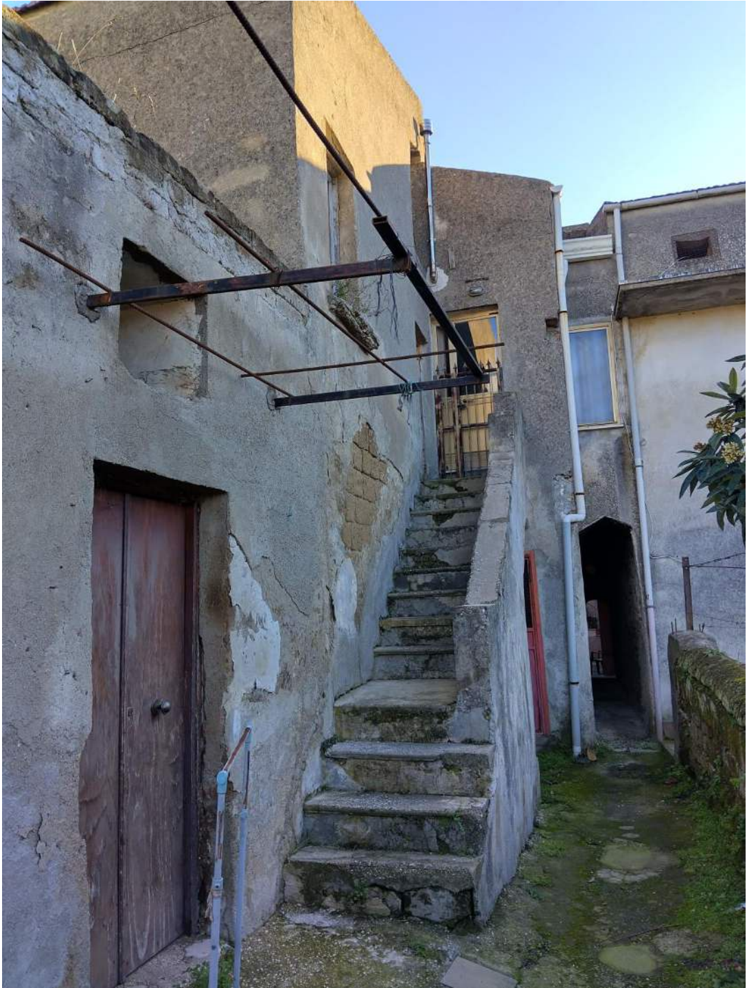
33 Scalinata esterna in comune
