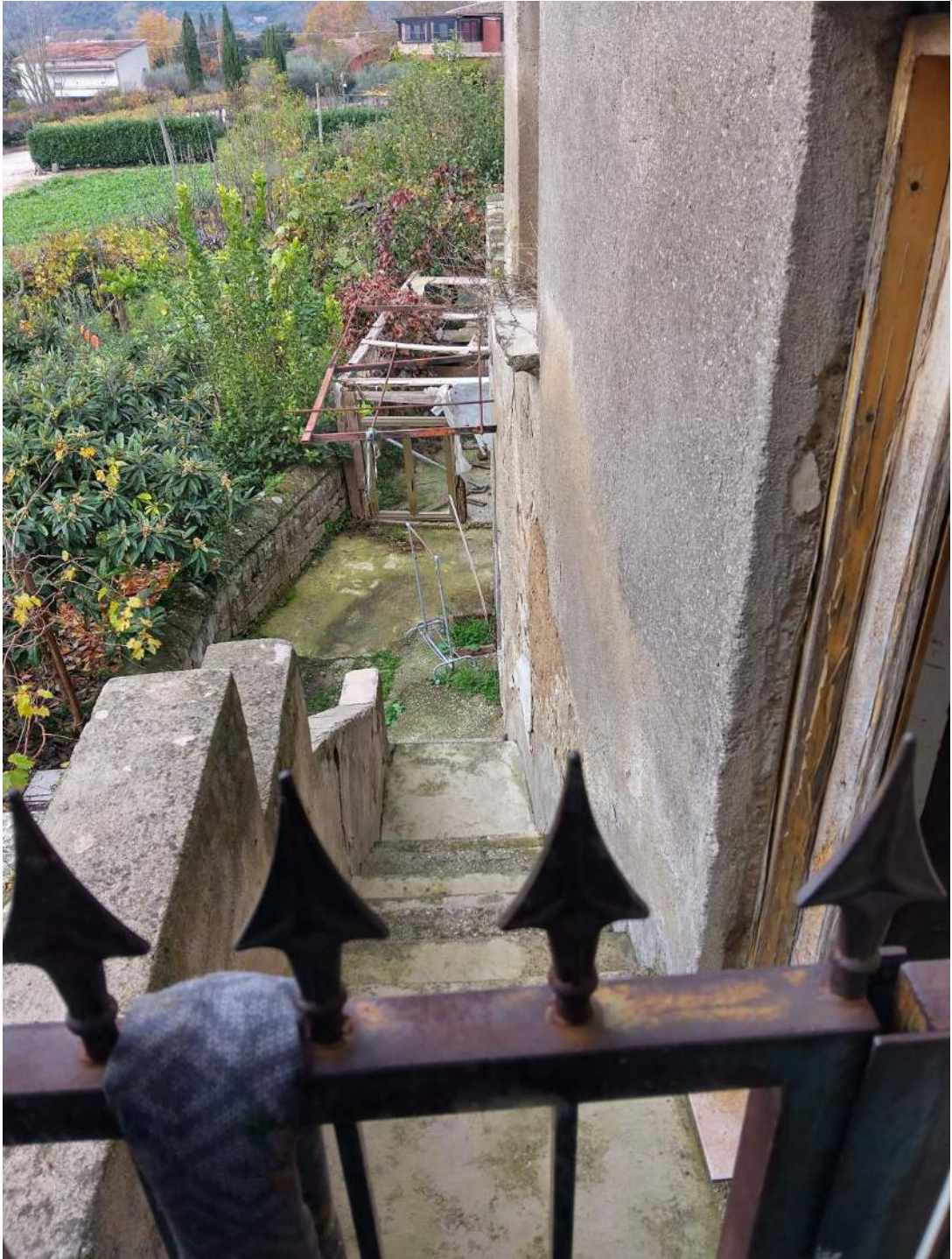
18 Scalinata esterna in comune
