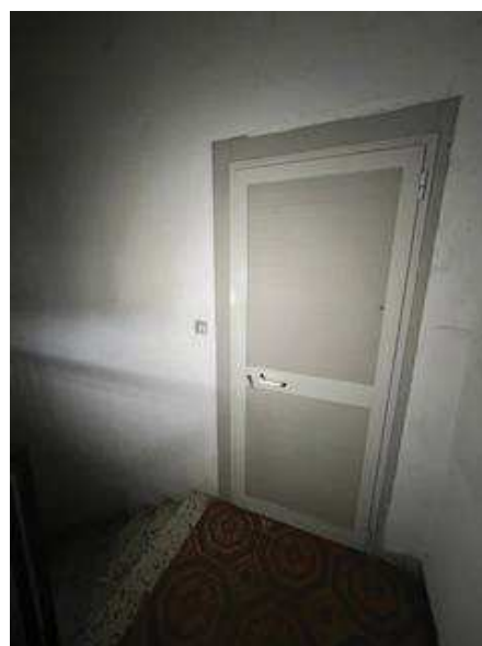
porta di comunicazione con altra unità intestata ad altra ditta
