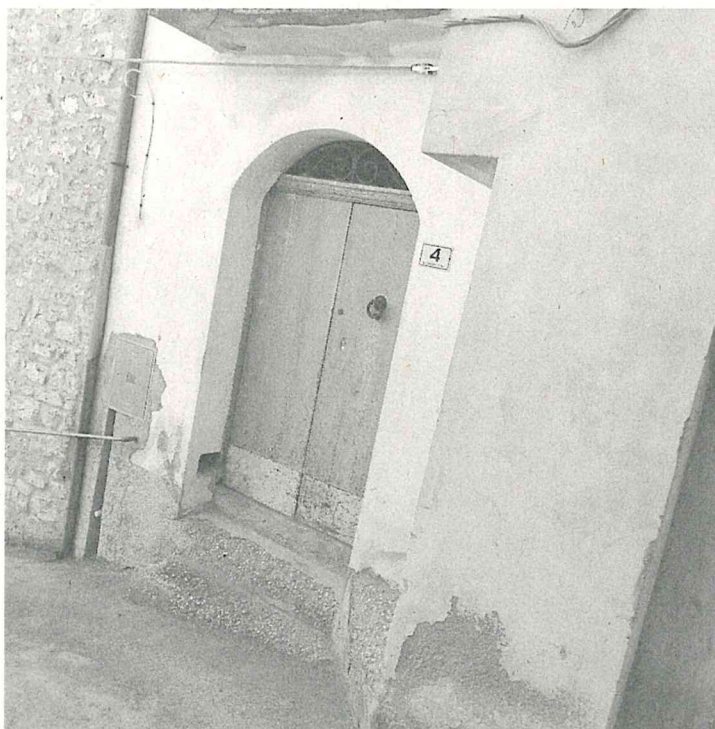
Foto n° 2 di 5 – Ingresso del fabbricato (Via S. Paolo, Vico 4, civico 4)
