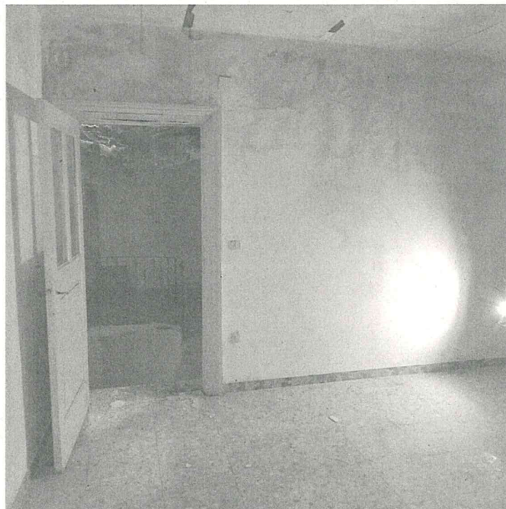
Foto n° 5 di 5 – Vista interna Piano Secondo
