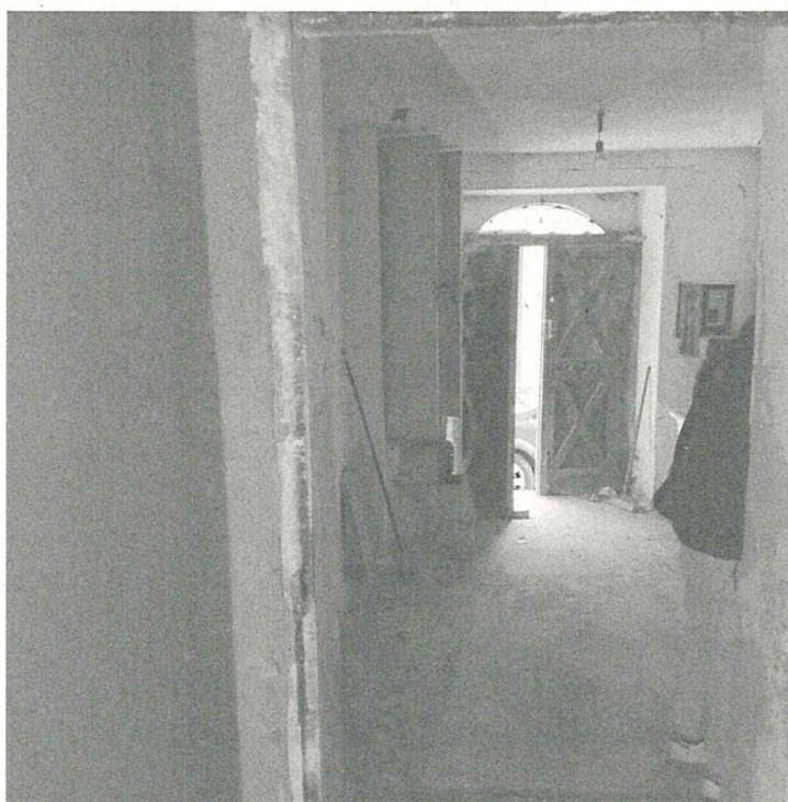
Foto n° 3 di 5 – Vista interna Piano Terra
