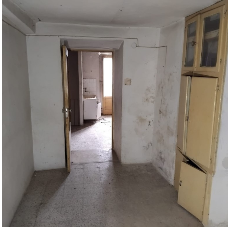
Foto n° 11 di 14 – Disimpegno (Piano primo)
