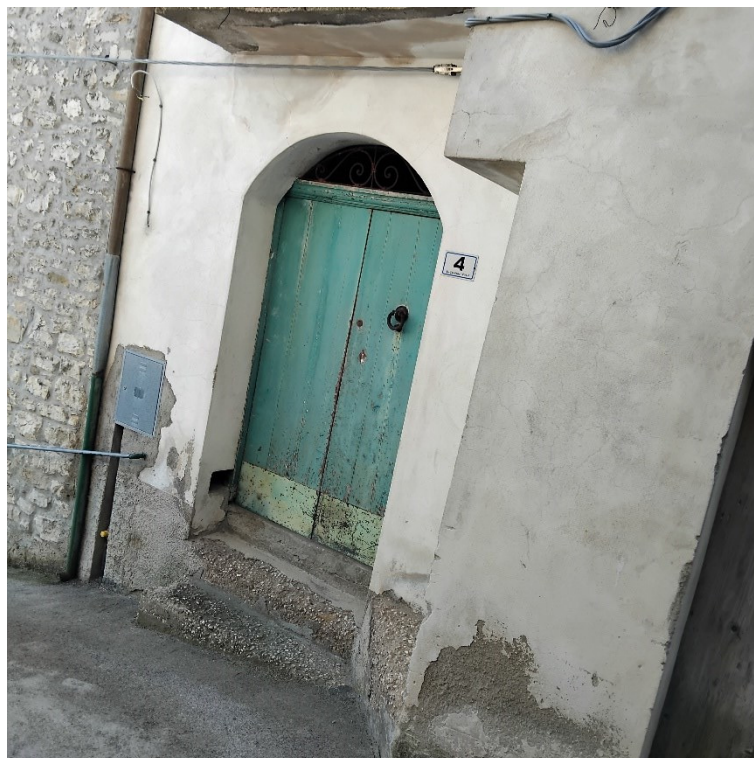
Foto n° 3 di 14 – Ingresso del fabbricato (Via S. Paolo, Vico 4, civico 4)
