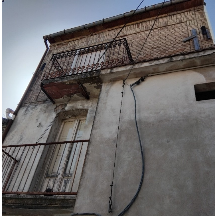
Foto n° 2 di 14 – Vista esterna del fabbricato (Affaccio su via S. Paolo, Vico 4)
