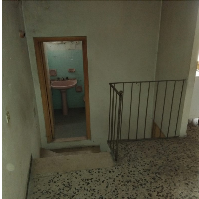
Foto n° 10 di 14 – Livello piano primo (Vano wc)
