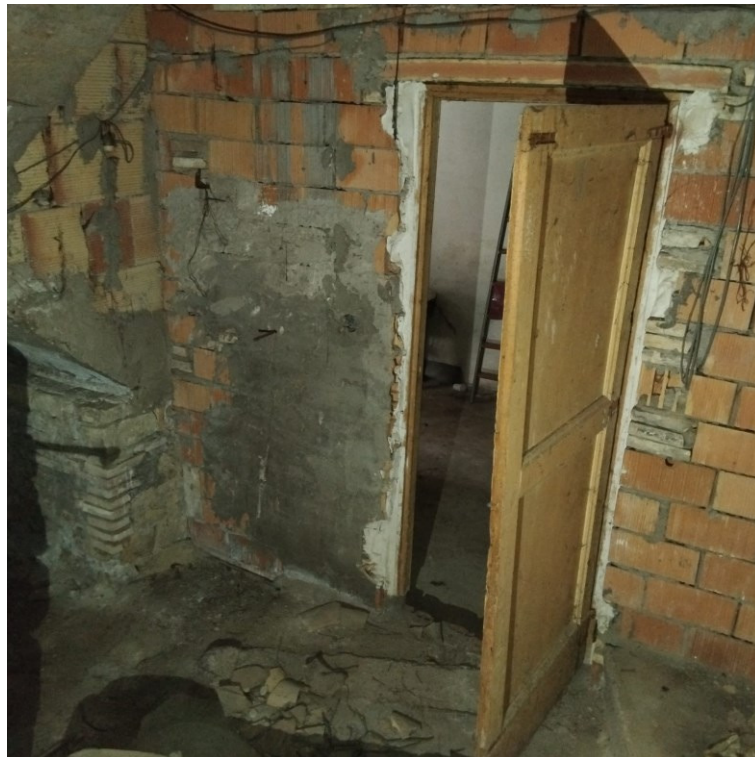
Foto n° 5 di 14 – Vano ripostiglio (Piano terra)
