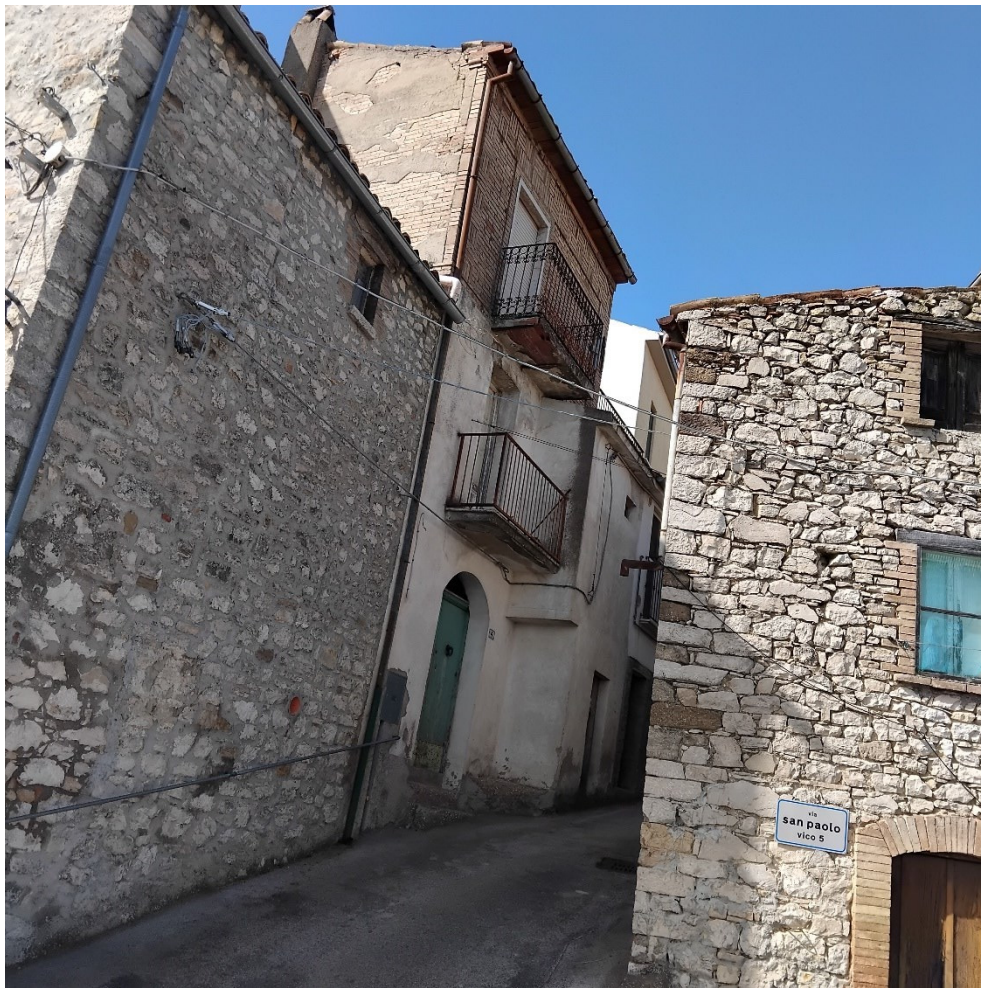
Foto n° 1 di 14 – Vista esterna del fabbricato
