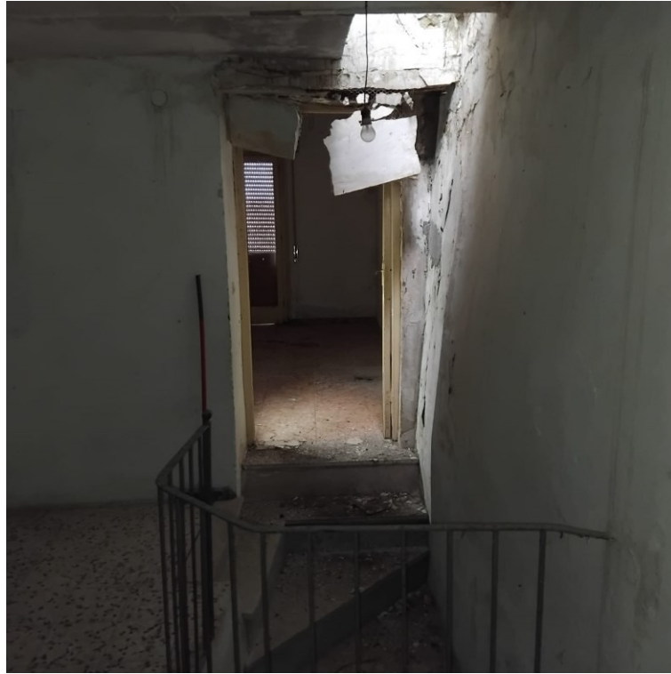
Foto n° 14 di 14 – Camera / Ripostiglio (Piano secondo)
