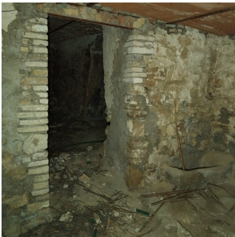
Foto n° 6 di 14 – Vano ripostiglio (Piano terra)
