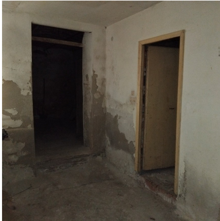
Foto n° 4 di 14 – Vano ingresso (Piano terra)
