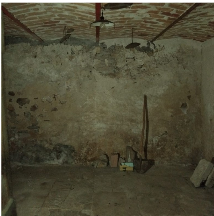
Foto n° 7 di 14 – Vano sgombero (Piano terra)
