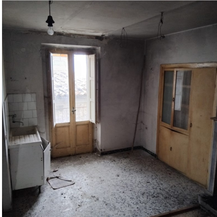
Foto n° 8 di 14 – Vano cucina (Piano primo)
