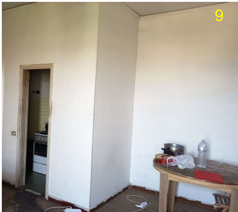
9- Accesso alla cucina dal soggiorno
