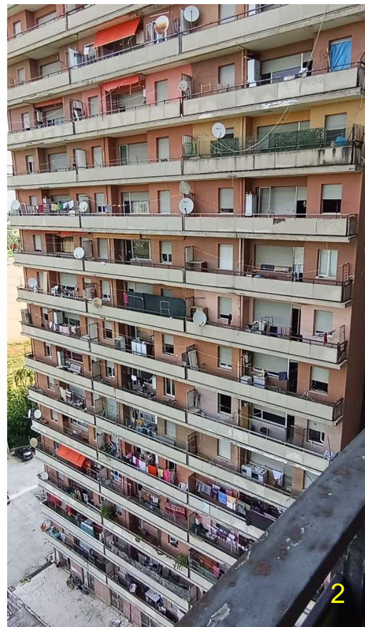
2- Vista dal terrazzo dell'immobile di un'ala dell'edificio
