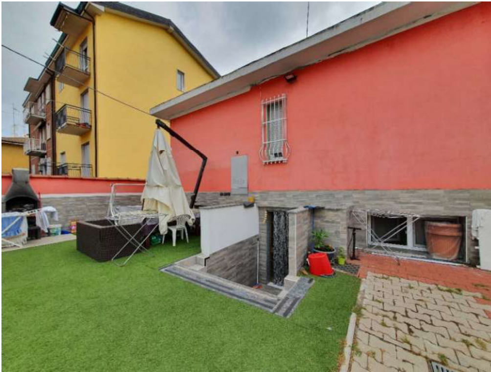
INGRESSO AL PIANO SEMINTERRATO
