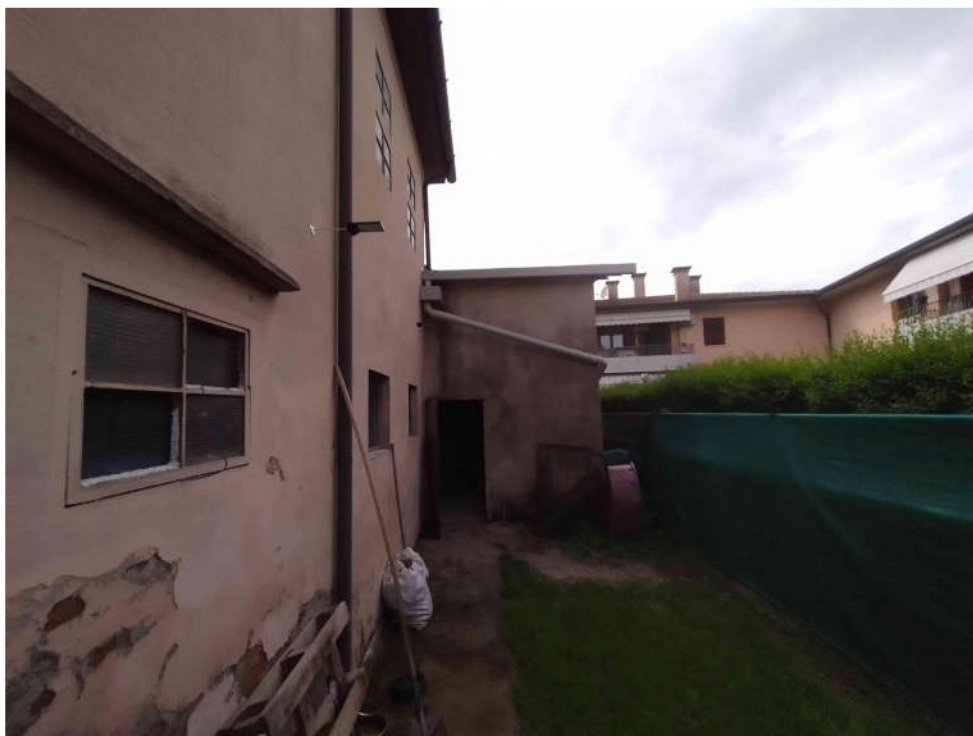
8. esterno a Nord
