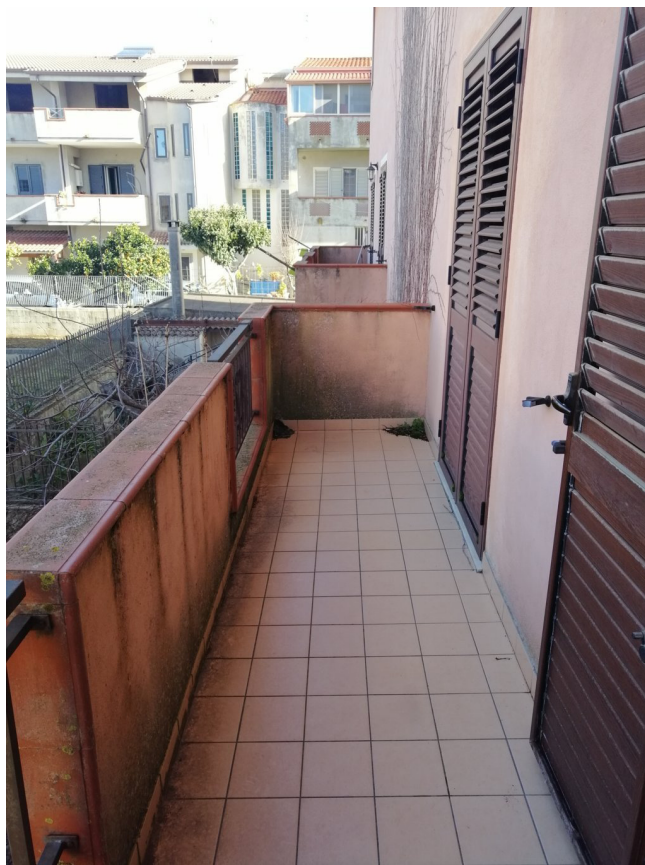
Foto 11 – Balcone della prima camera al piano primo.
