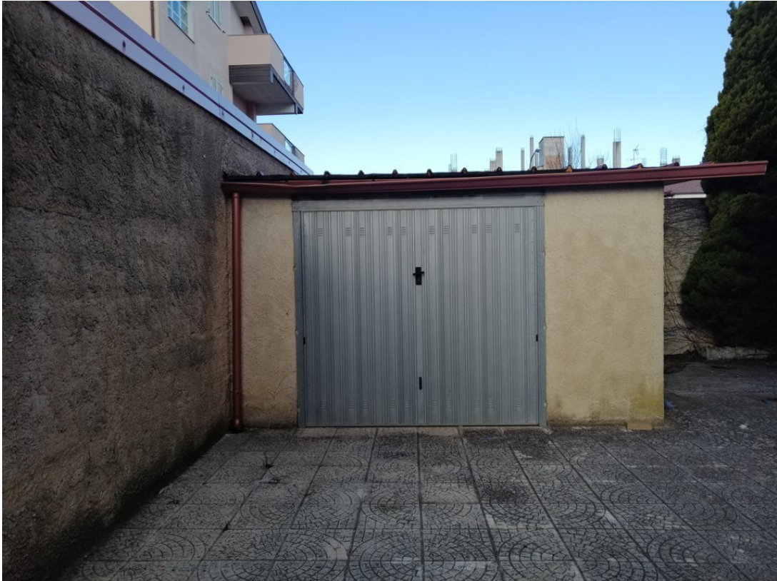
Foto 25 – Box auto abusivamente costruito sulla corte.
