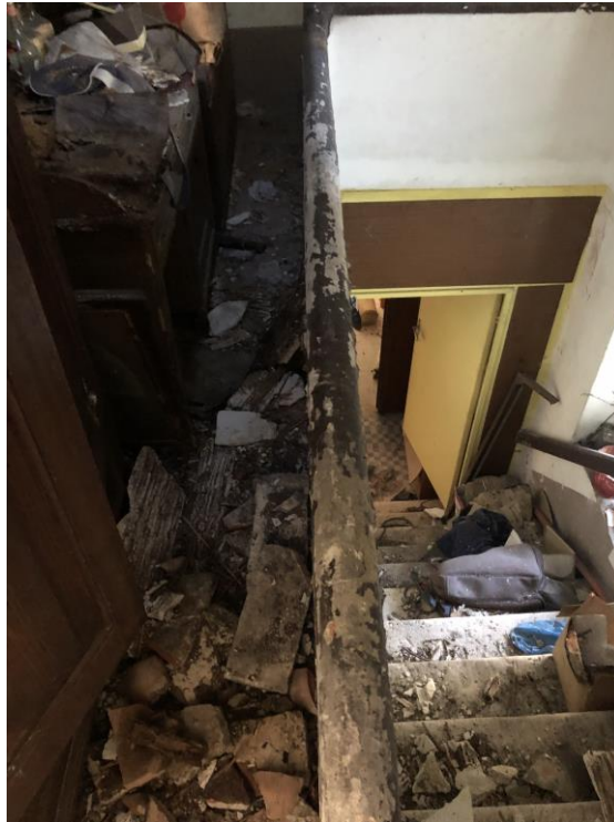
Vista del tetto parzialmente crollato al piano secondo e vista scale tra piano secondo e piano primo
