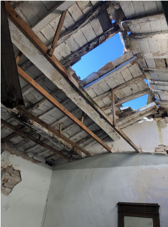
Vista del tetto parzialmente crollato al piano secondo e vista scale tra piano secondo e piano primo
