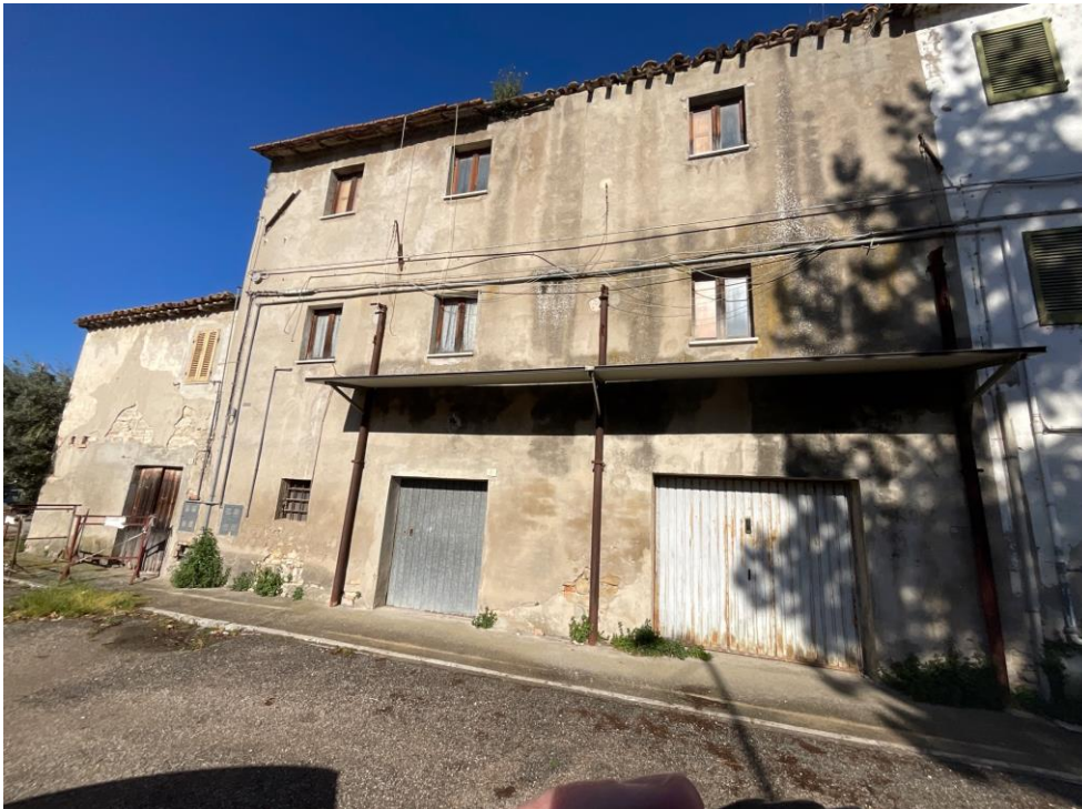
Vista prospetto sud/est
