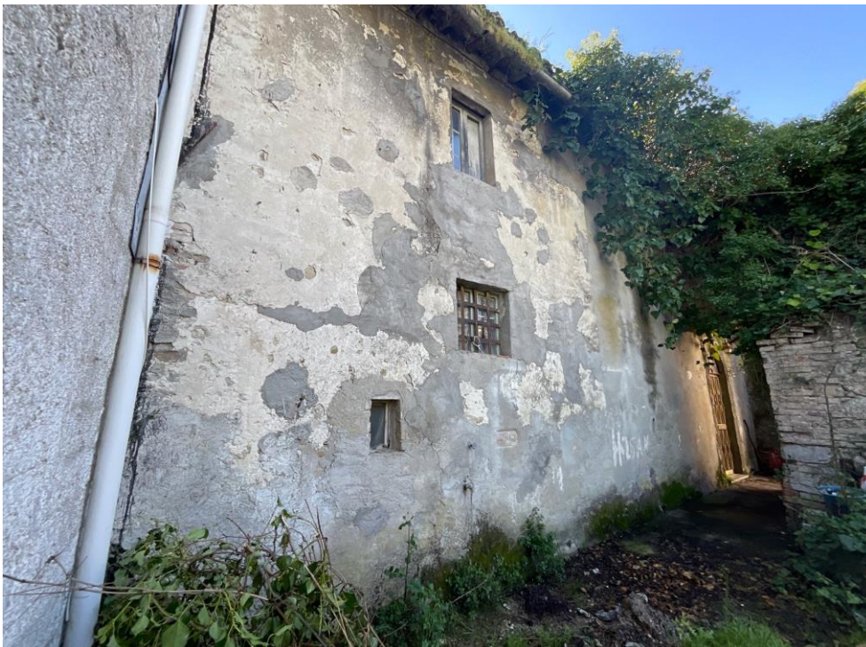
Vista prospetto nord/ovest
