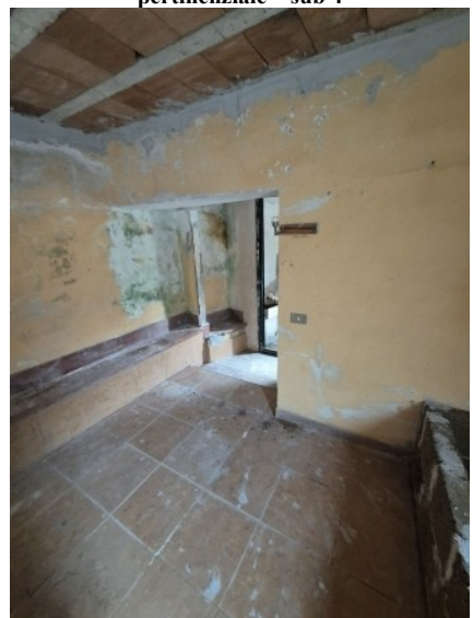
Figura 62 deposito 2 al primo piano pertinenziale – sub 4
