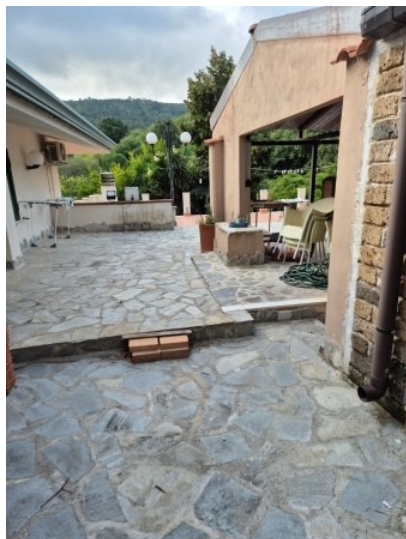
Figura 50 cortile 2 al primo piano
