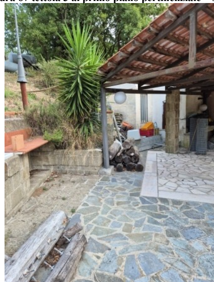
Figura 69 tettoia 3 al primo piano pertinenziale – sub 6
