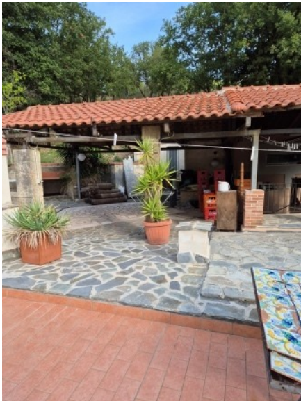
Figura 66 tettoia 3 al primo piano pertinenziale – sub 6
