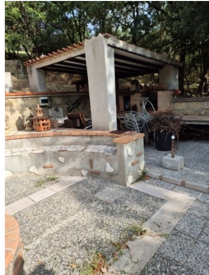
Figura 53 tettoia 4 al piano terra
