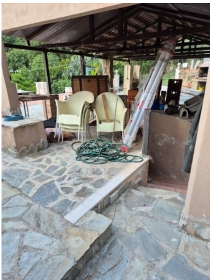
Figura 68 tettoia 3 al primo piano pertinenziale – sub 6
