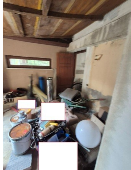
Figura 61 deposito 1 al primo piano pertinenziale – sub 4
