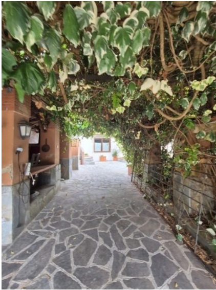
Figura 70 pergola 1 al piano terra pertinenziale – sub 7
