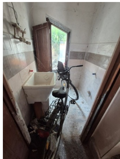
Figura 63 wc al primo piano pertinenziale – sub 4
