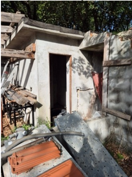
Figura 54 deposito 3 al primo piano
