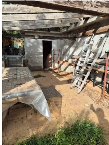
Figura 55 deposito 4 al primo piano
