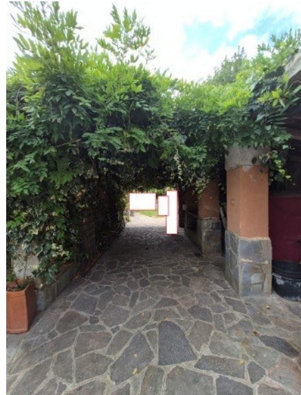
Figura 71 pergola 1 al piano terra pertinenziale – sub 7
