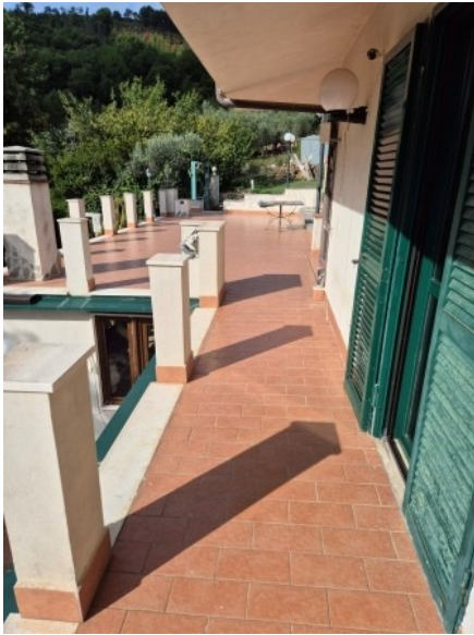
Figura 46 balcone 1 al primo piano
