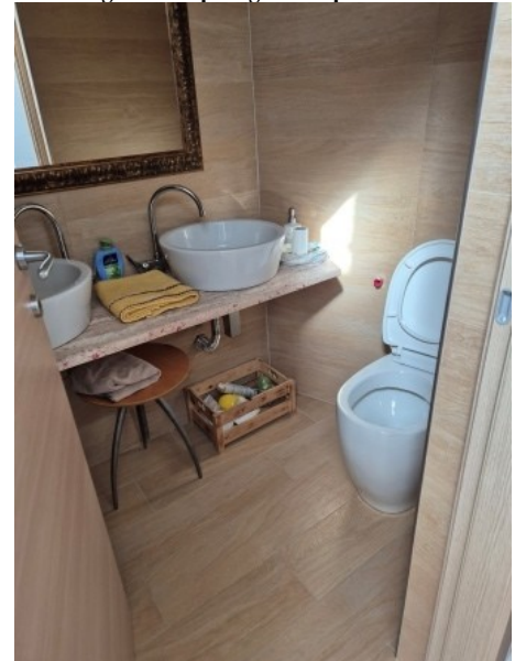
Figura 25 bagno 2 al piano terra
