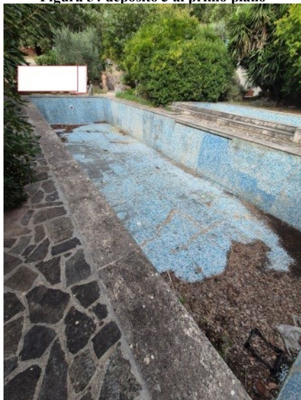
Figura 56 piscina 1 al piano terra
