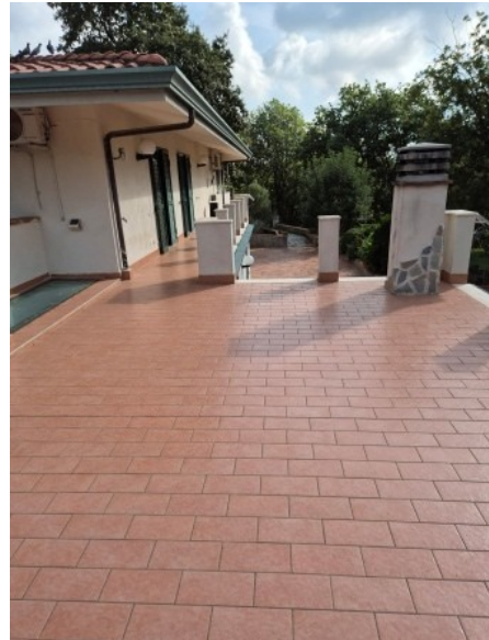
Figura 47 balcone 1 al primo piano
