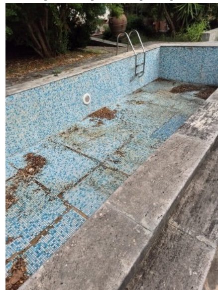
Figura 57 piscina 2 al piano terra
