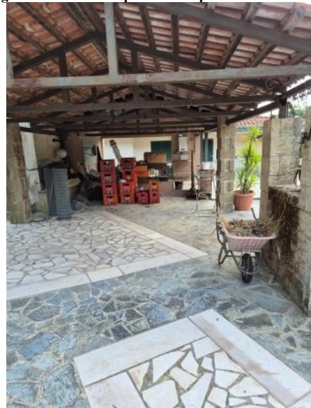
Figura 67 tettoia 3 al primo piano pertinenziale – sub 6
