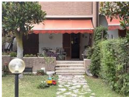
INGRESSO UNITA' IMMOBILIARE - VIA ALVARO 9
