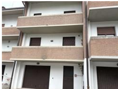
VISTA RETRO-INGRESSO GARAGE -
