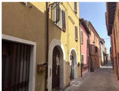
vista fabbricato via de' rusticucci
