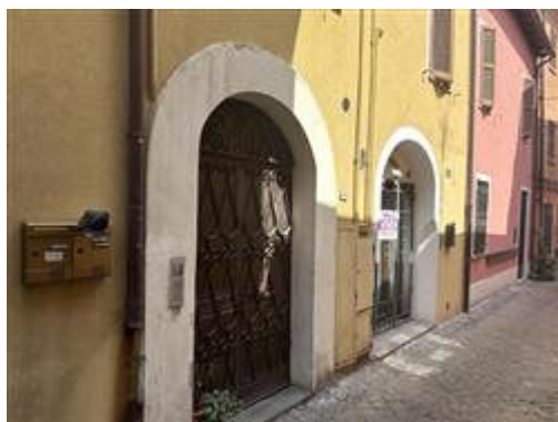
vista fabbricato via de' rusticucci
