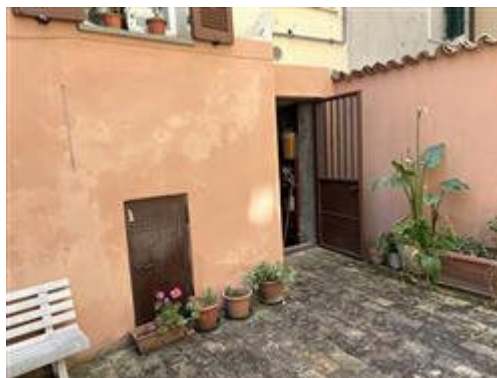
ingresso cantina retro fabbricato
