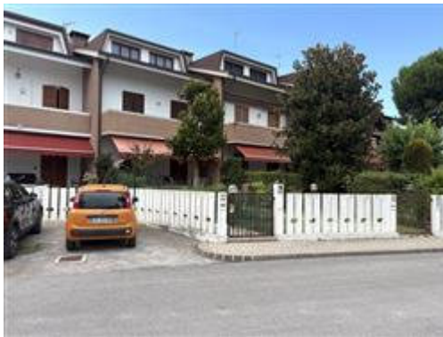
VISTA FRONTALE COMPLESSO RESIDENZIALE
