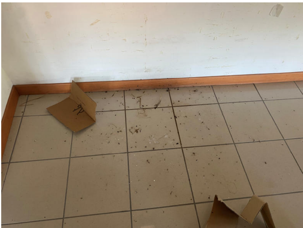
Foto 15 – Piano Secondo (sottotetto)
