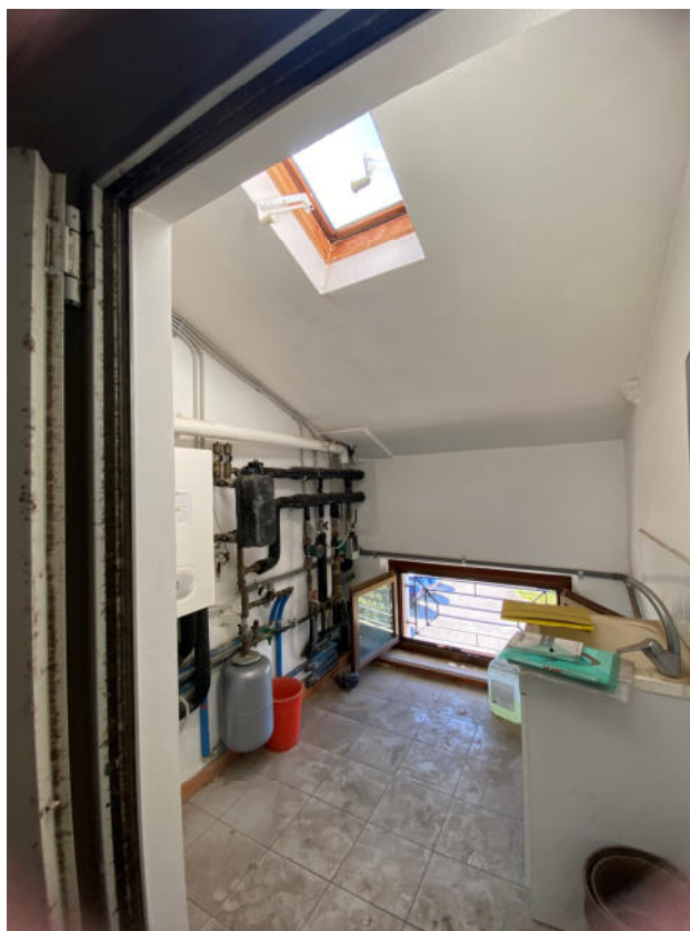
Foto 17 – Piano Secondo (sottotetto) - Vano C.T.
