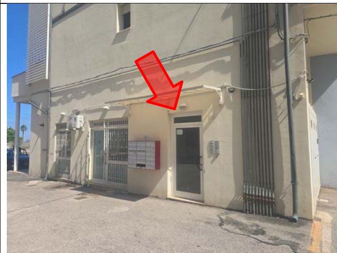
Ingresso Scala Condominiale
