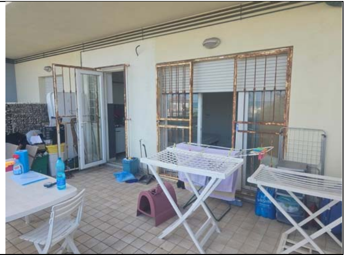
Balcone Fronte Principale
