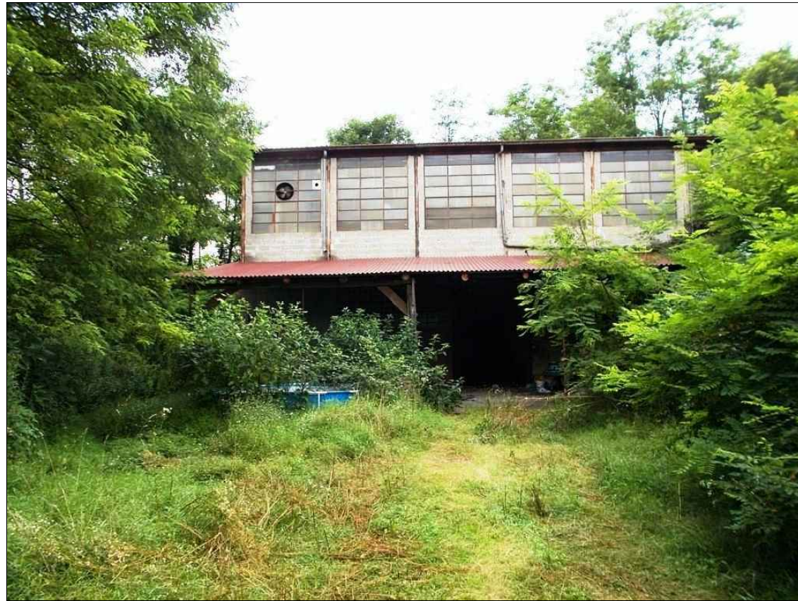
Esterno u.i. P.Interrato (ingresso)
