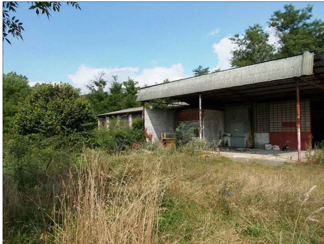
Esterno u.i. P.Terreno (parte lato sud)
