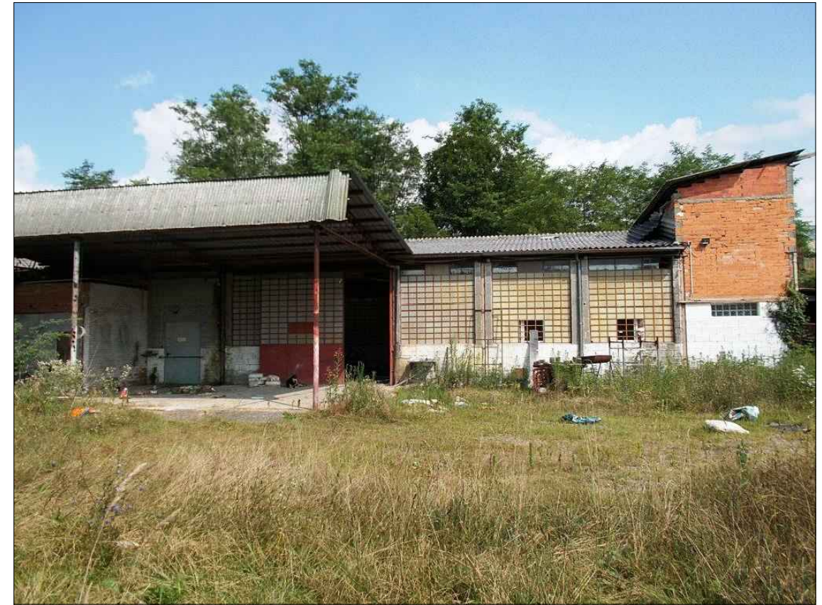
Esterno u.i. P.Terreno (parte lato sud)
