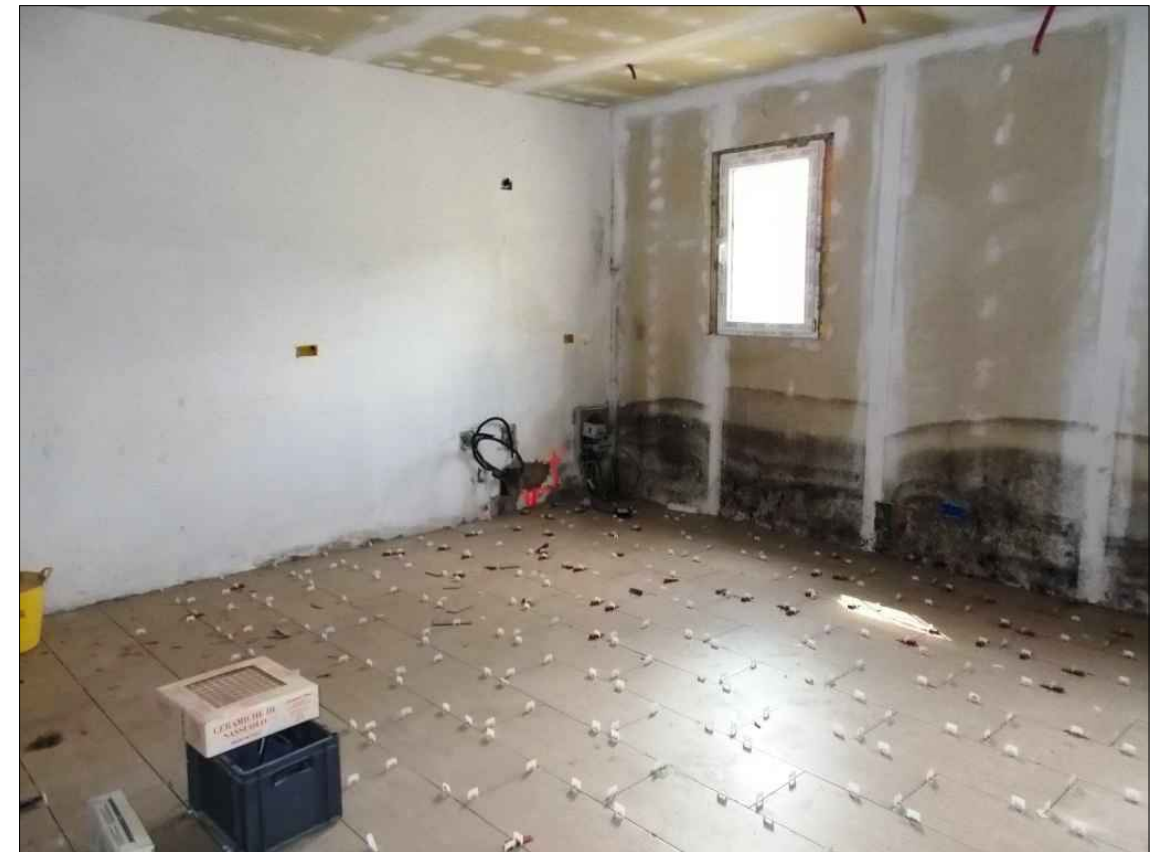
Interno u.i. P.Terreno (locali oggetto di lavori sospesi)
