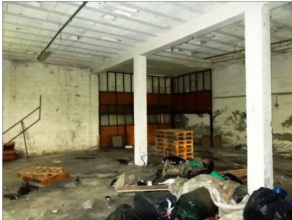
Interno u.i. P.Interrato
