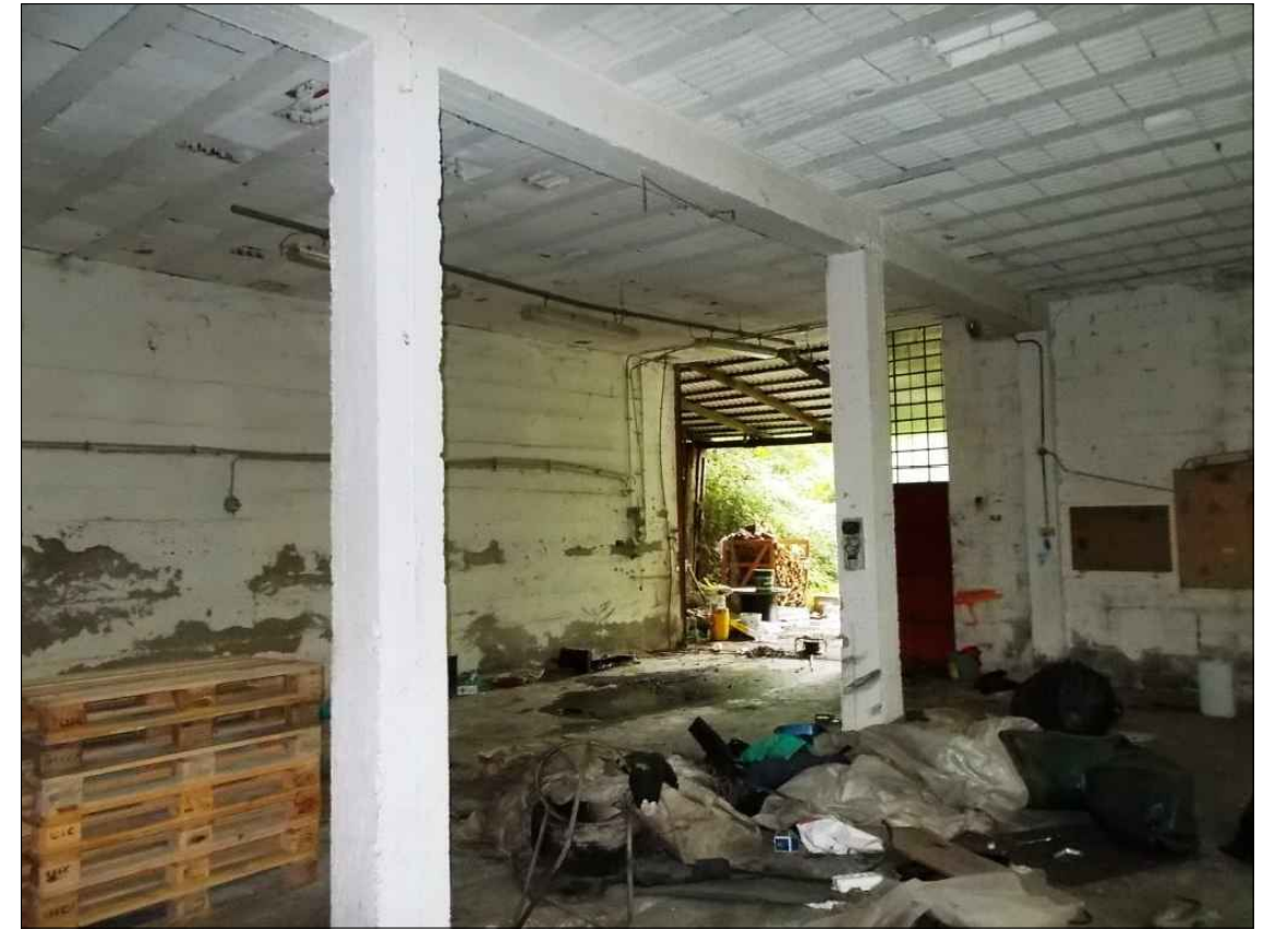
Interno u.i. P.Interrato
