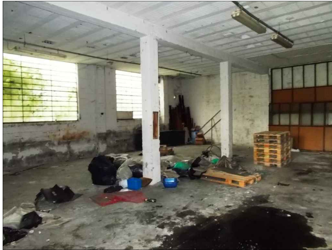
Interno u.i. P.Interrato
