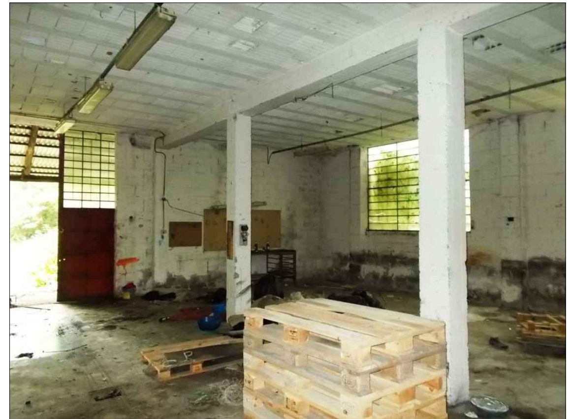
Interno u.i. P.Interrato
