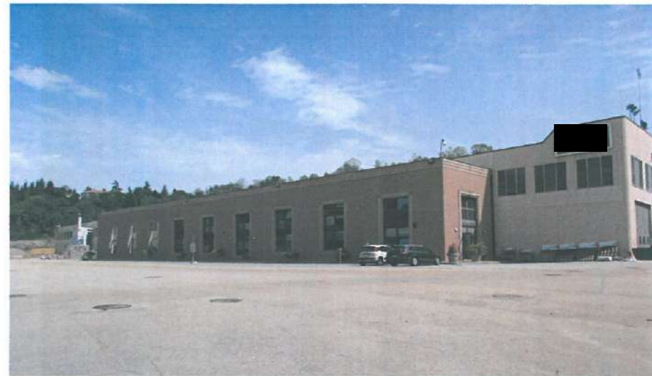
Capannone 2 - Palazzina uffici 1
