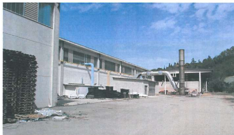
Capannone 2 - Locale compressori 5 - Fabbr. Accessori 4 - Tettoia 3
