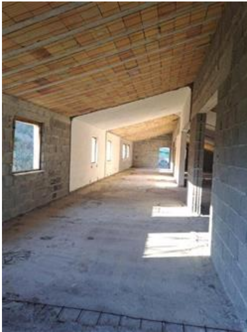
Soffitta al Piano Primo al momento del sopralluogo
