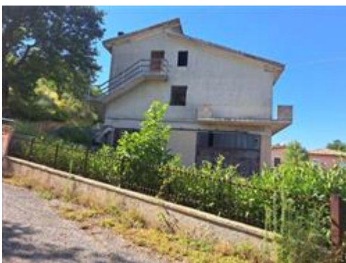
fianco destro con piano terra
