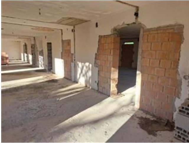
stato verificato al momento del sopralluogo, piano Primo
