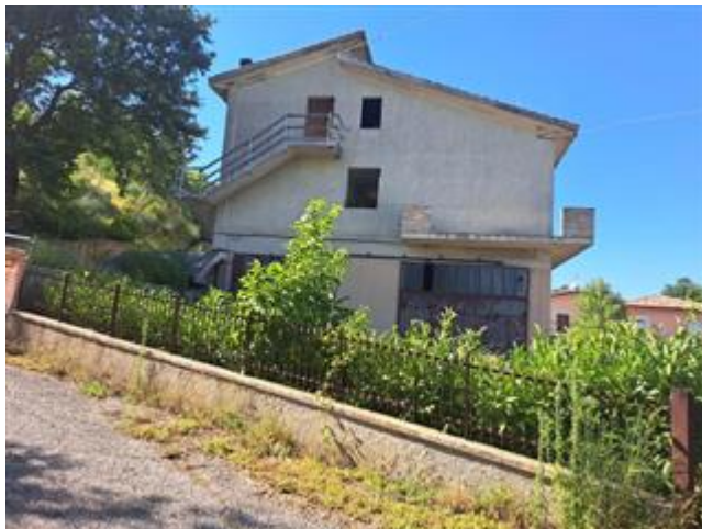
strada fronte fabbricato
