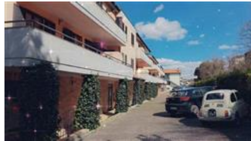
Parcheggio, area interna comune
