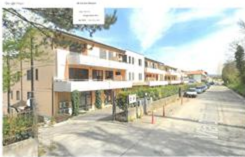
Vista del fabbricato da strada di accesso
