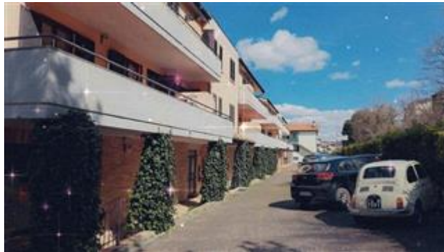
Parcheggio area interna comune
