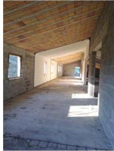
stato verificato al momento del sopralluogo, piano Secondo
