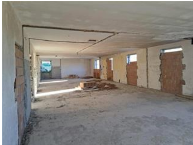
appartamento e magazzini al Piano Primo al momento del sopralluogo
