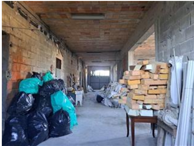
magazzini e autorimessa al Piano Terra
