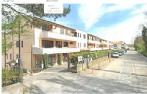
Vista del Fabbricato da strada di accesso
