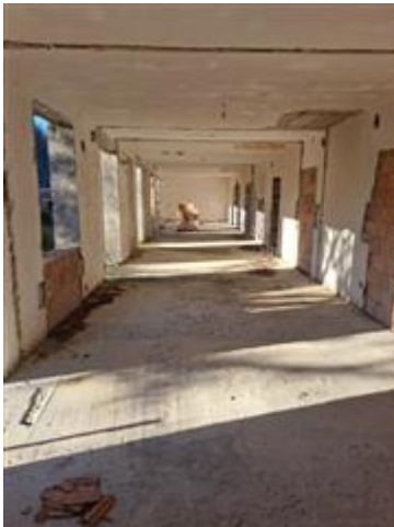
appartamento e magazzini al Piano Primo al momento del sopralluogo
