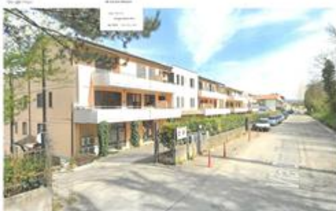
Vista del fabbricato da strada di accesso
