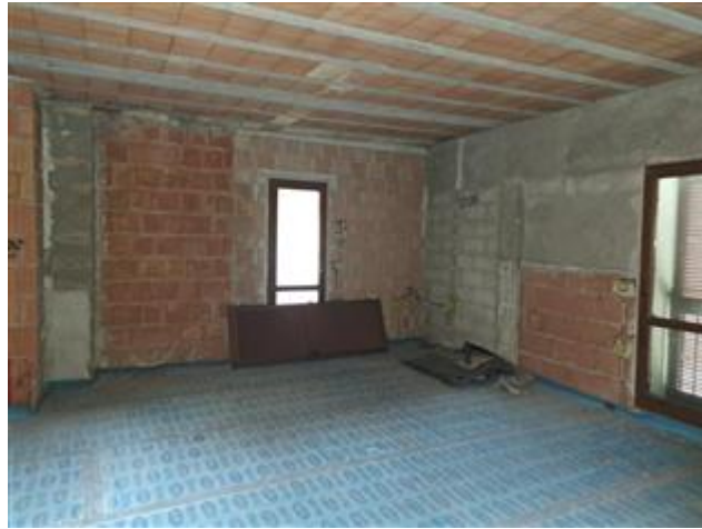
stato al grezzo rilevato in fase di sopralluogo
