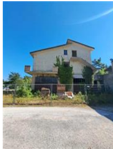
fianco sin. con piano terra
