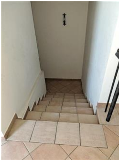
Vano scala comune
