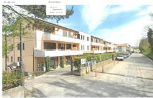
vista del fabbricato da strada di accesso
