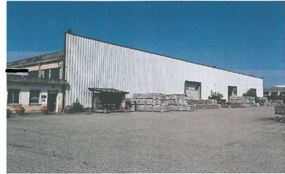
Capannone 2 - Palazzina uffici 1
