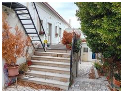
Scala di accesso al terrazzo
