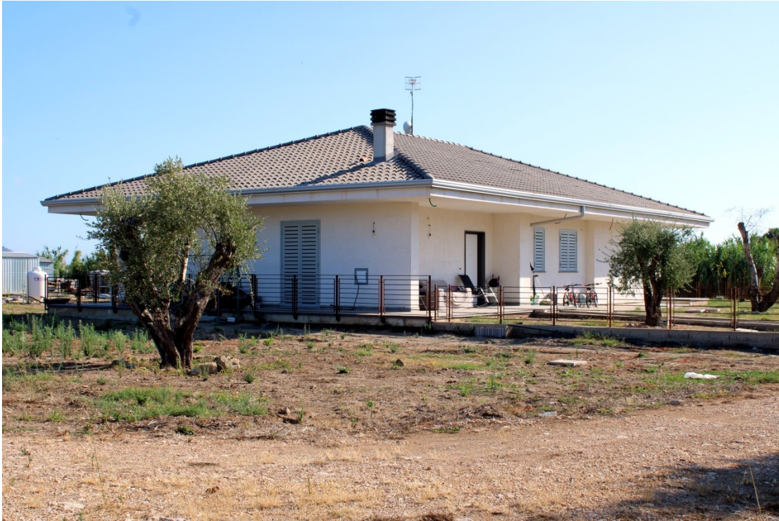
Figura 6 (Panoramica esterna del lato nord del fabbricato)
