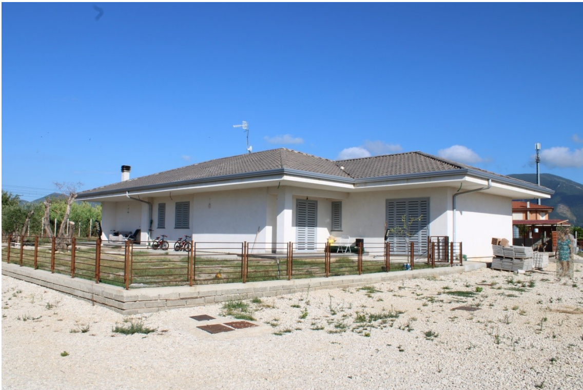
Figura 8 (Panoramica esterna del lato ovest del fabbricato)
