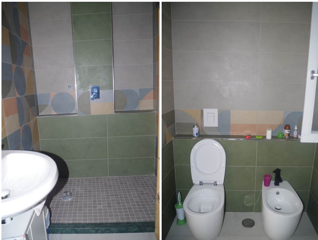
Figura 18 (due foto del bagno nr. 3)
