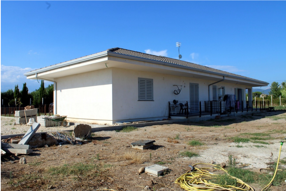
Figura 9 (Panoramica esterna direzione sud del fabbricato)
