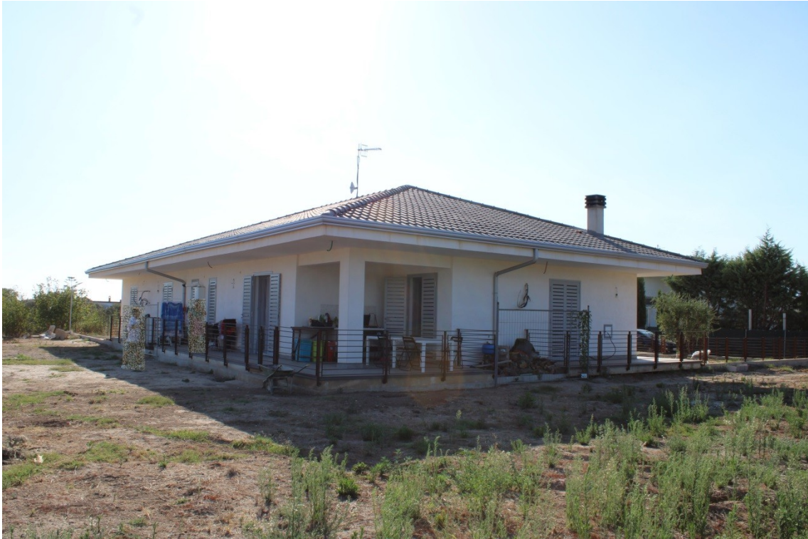
Figura 7 (Panoramica esterna del lato est del fabbricato)
