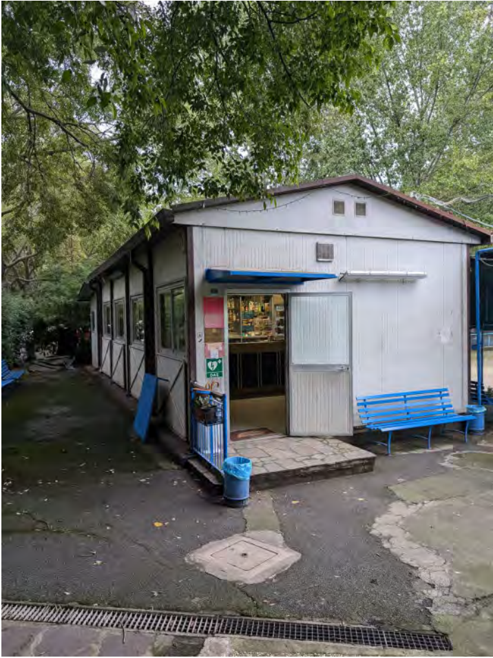
01 - Manufatto prefabbricato (lato ingresso)
