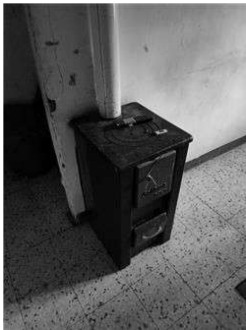
Dettaglio della stufa al piano 1 e dei pavimenti in graniglia
