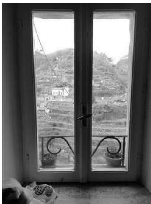
Dettaglio dei serramenti
