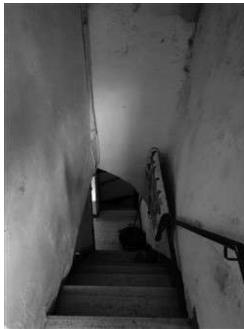
Vista della scala dal piano 2
