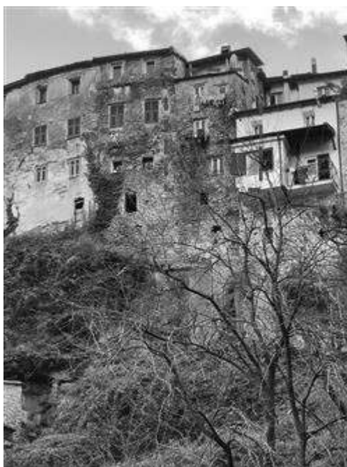
Vista della palazzata nord del borgo con individuato l'immobile oggetto di perizia
