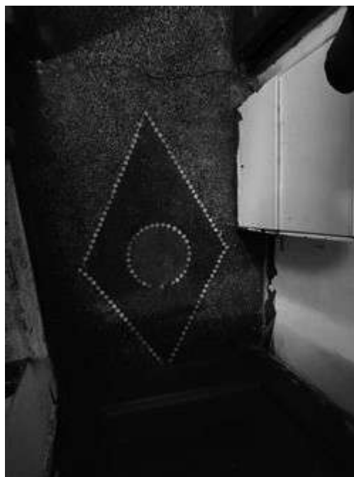
Dettaglio del pavimento del piano terra
