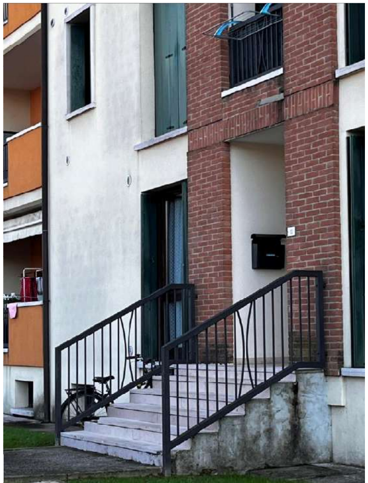
Ingresso condominio Corpo "B"
