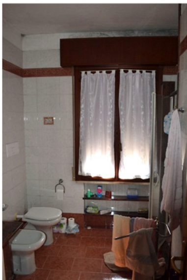
foto 10 - sub 2 (bagno) - Il servizio igienico dispone di tazza, bidet, lavabo, cabina doccia, lavello e lavatrice. Pavimenti smaltati a giunti discontinui. Altezza di piastrellatura pareti 2.63 metri.
