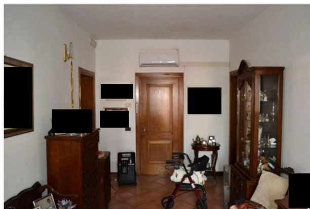
foto 5 - sub 2 (ingresso) - Sopra la porta del bagno si vede l’unico apparecchio a espansione diretta per la climatizzazione dell’appartamento, marca Qingdao mod.HSU-12TK1, refrigerante R32. L’impianto copre 550 m 3 /h a fronte di 295m 3 utili da riscaldare o raffreddare, calcolati contando anche l’angolo doccia. Le porte interne sono in legno massiccio chiaro.
