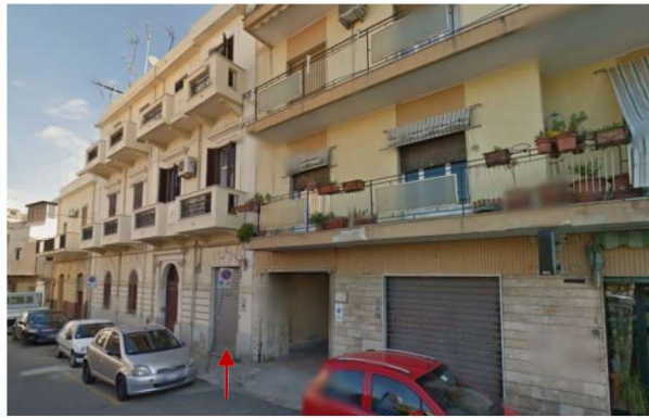
Foto 2 - Ingresso al magazzino
