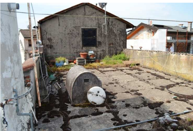
foto 34 - La terrazza con l'accesso al sottotetto sud
