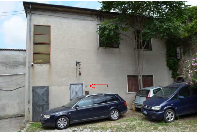
foto 10 - Prospetto est della parte nord con il civ. 81
