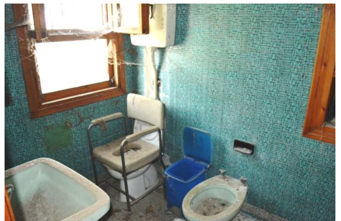
foto 25 - Scorcio interno del bagno dell'abitazione
