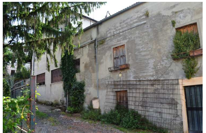
foto 13 - Scorcio ovest della parte nord e centrale
