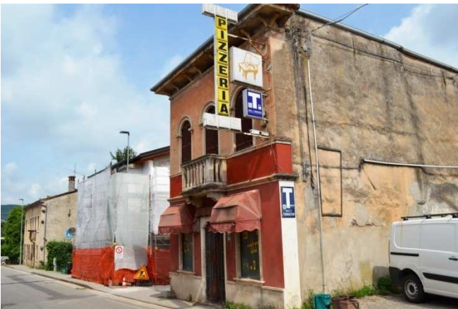
foto 5 - Scorcio del prospetto sud visto da sud est
