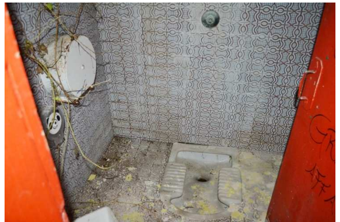
foto 18 - Locale servizi visto dall'ingresso
