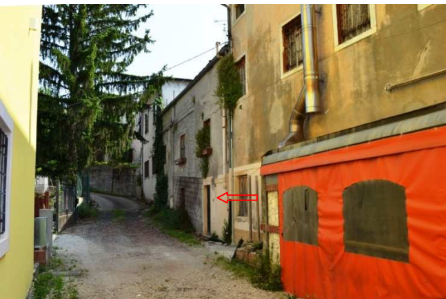
foto 12 - Scorcio ovest della parte centrale col civ. 77
