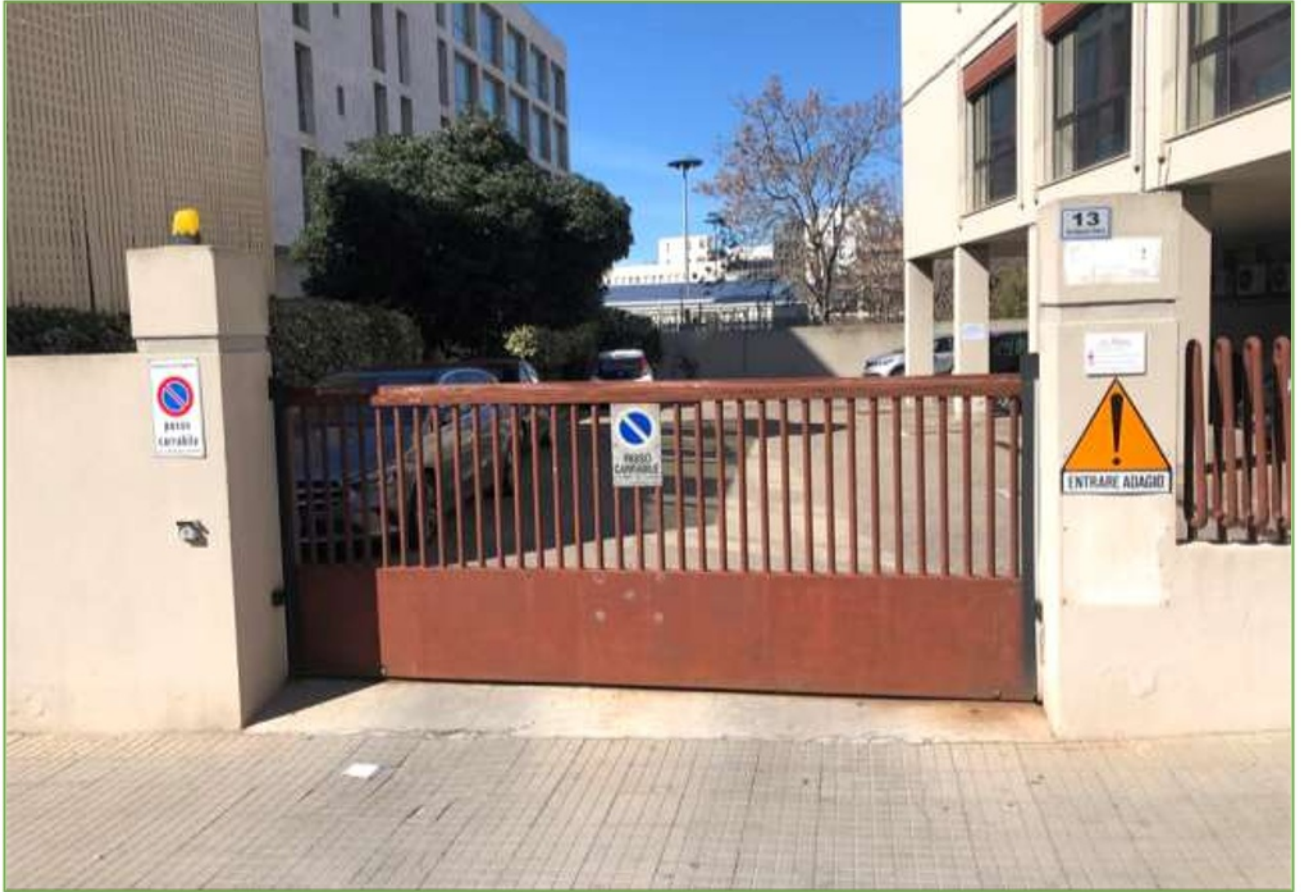
Foto n° 45: Accesso carrabile all'area cortilizia condominiale
