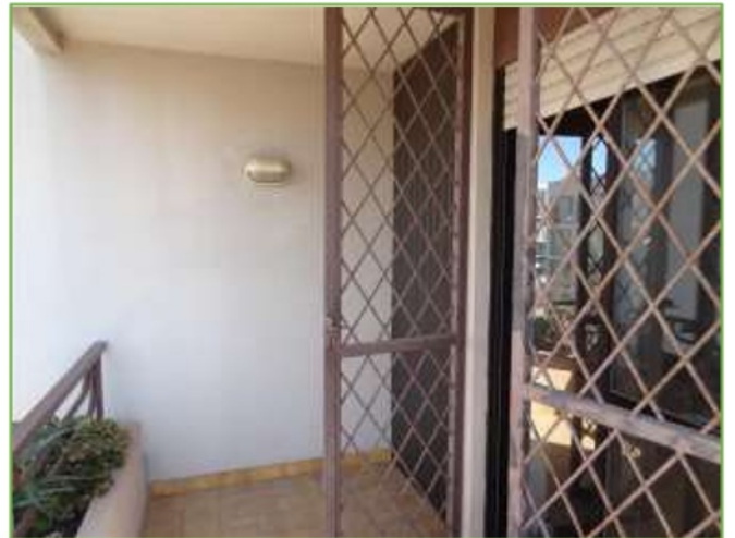
Foto n° 38: Balcone 3, particolare grate metallica di sicurezza
