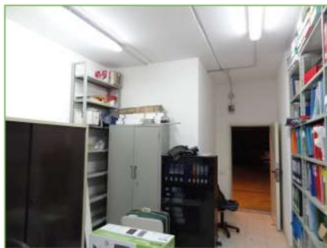
Foto n° 51: Particolare finiture Cantina distinta con sub. 93
