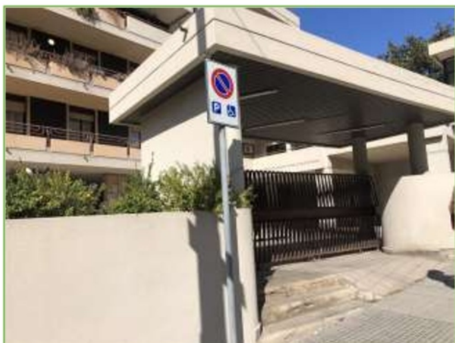
Foto n° 5: particolare dell'accesso pedonale
