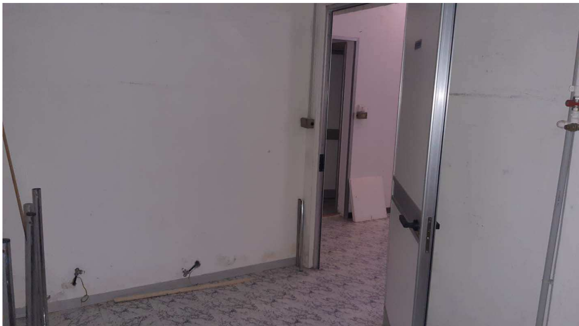
14 – Magazzino piano seminterrato
