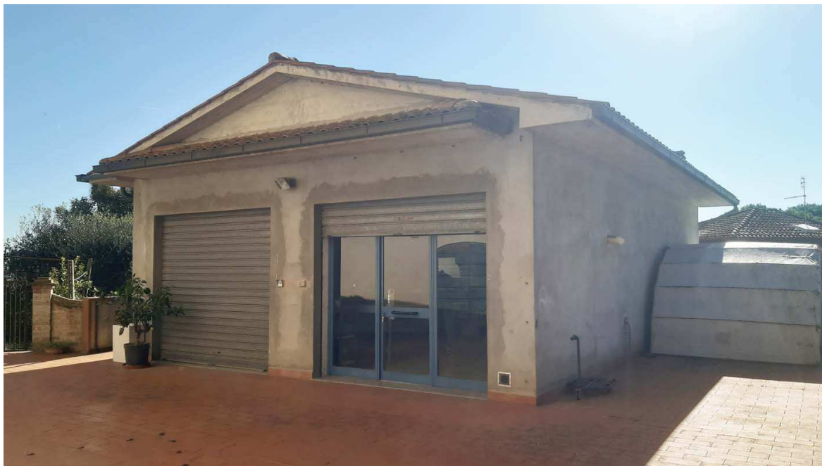
01 – Vista ingresso laboratorio piano terra
