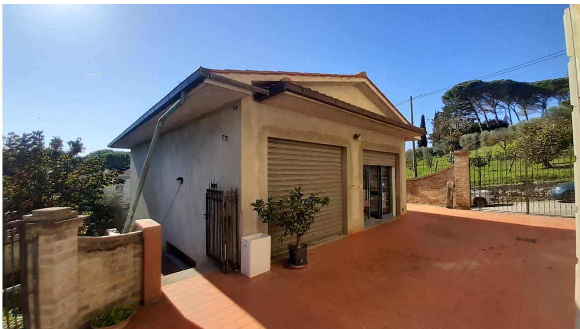
02 – Vista ingresso laboratorio piano terra
