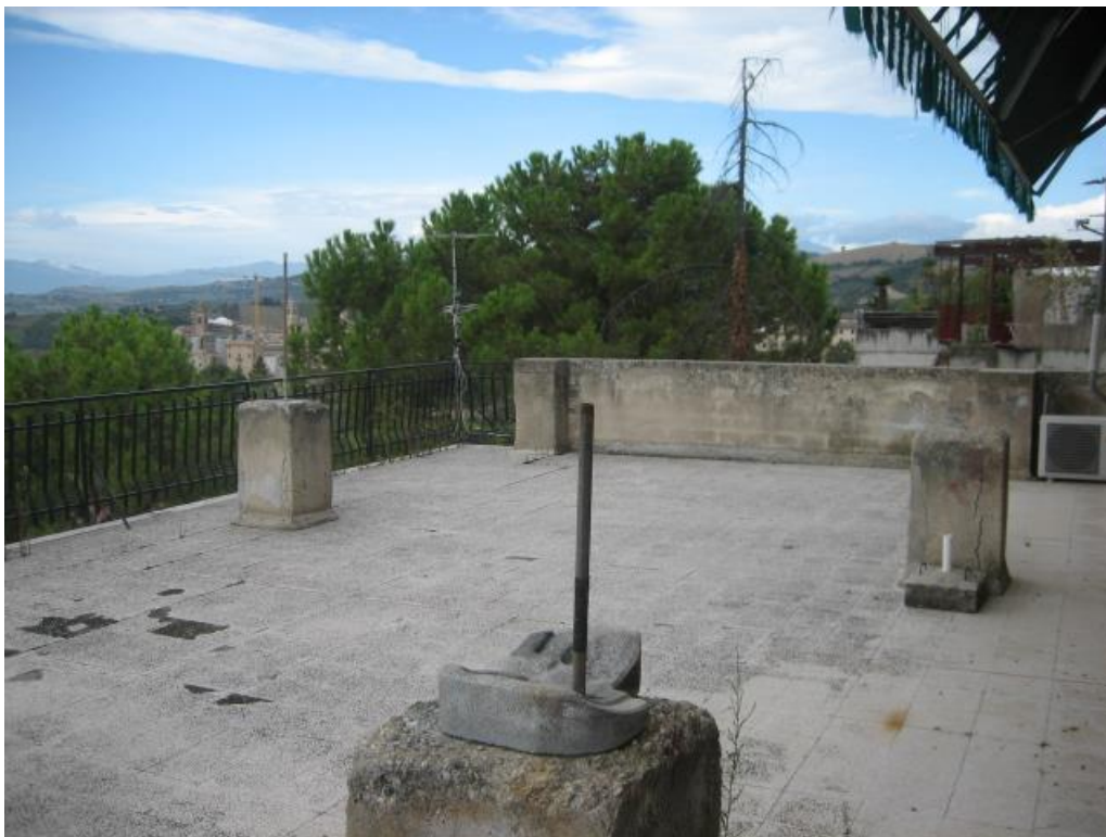
FOTO n. 11 – La terrazza prospetto sud
