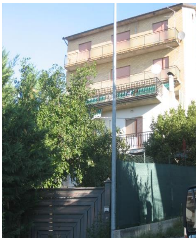
FOTO n. 2 – Prospetto sud Condomino via IV Novembre 33
