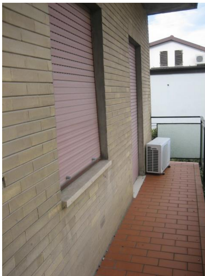
FOTO n. 12 – Il balcone prospetto nord
