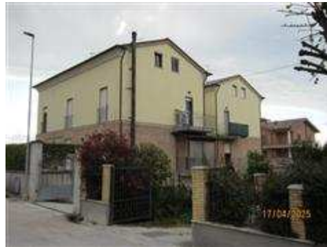
Vista del fabbricato dalla strada di accesso a nord-est
