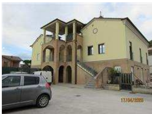
Vista del fabbricato dall'ingresso principale a sud-est
