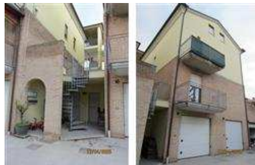
Vista scala esterna comune da livello garage - Vista fabbricato a Nord da livello garage
