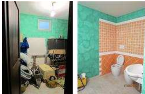
Viste locale deposito adibito a bagno
