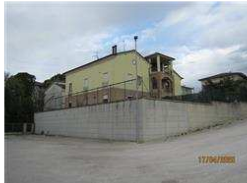
Vista del fabbricato dalla proprietà posta ad ovest
