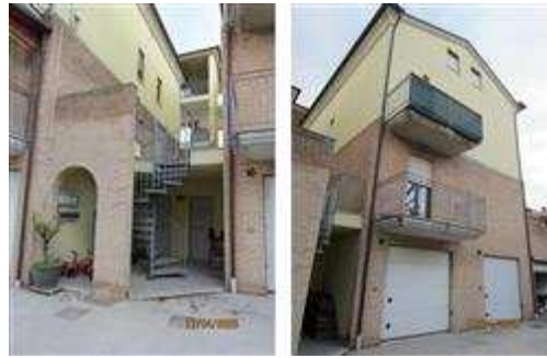
Vista scala esterna comune da livello garage - Vista fabbricato a Nord da livello garage
