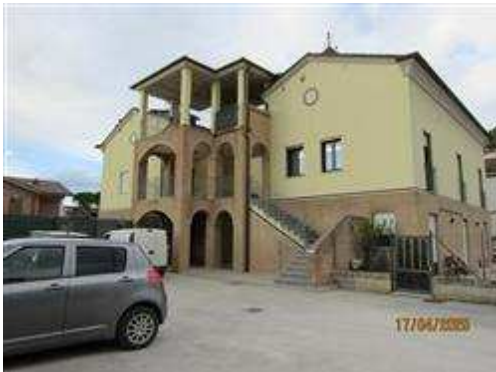
Vista del fabbricato dall'ingresso principale a sud-est
