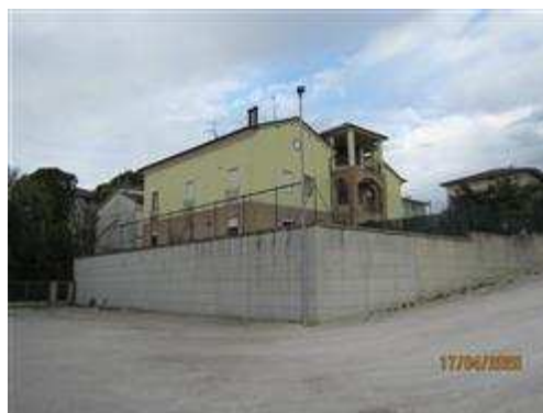
Vista del fabbricato dalla proprietà posta ad ovest
