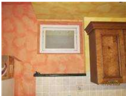
Particolare infisso su bocca di lupo (locale principale)
