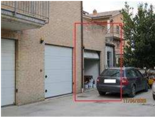
Vista esterna ingresso garage e adiacente locale abusivo
