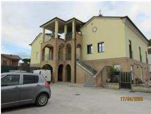
Vista del fabbricato dall'ingresso principale a sud-est
