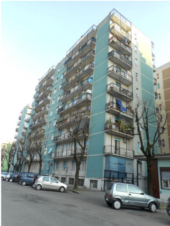
Vista dell'edificio da Via Cilea
