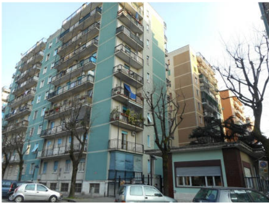
Vista dell'edificio da Via Cilea
