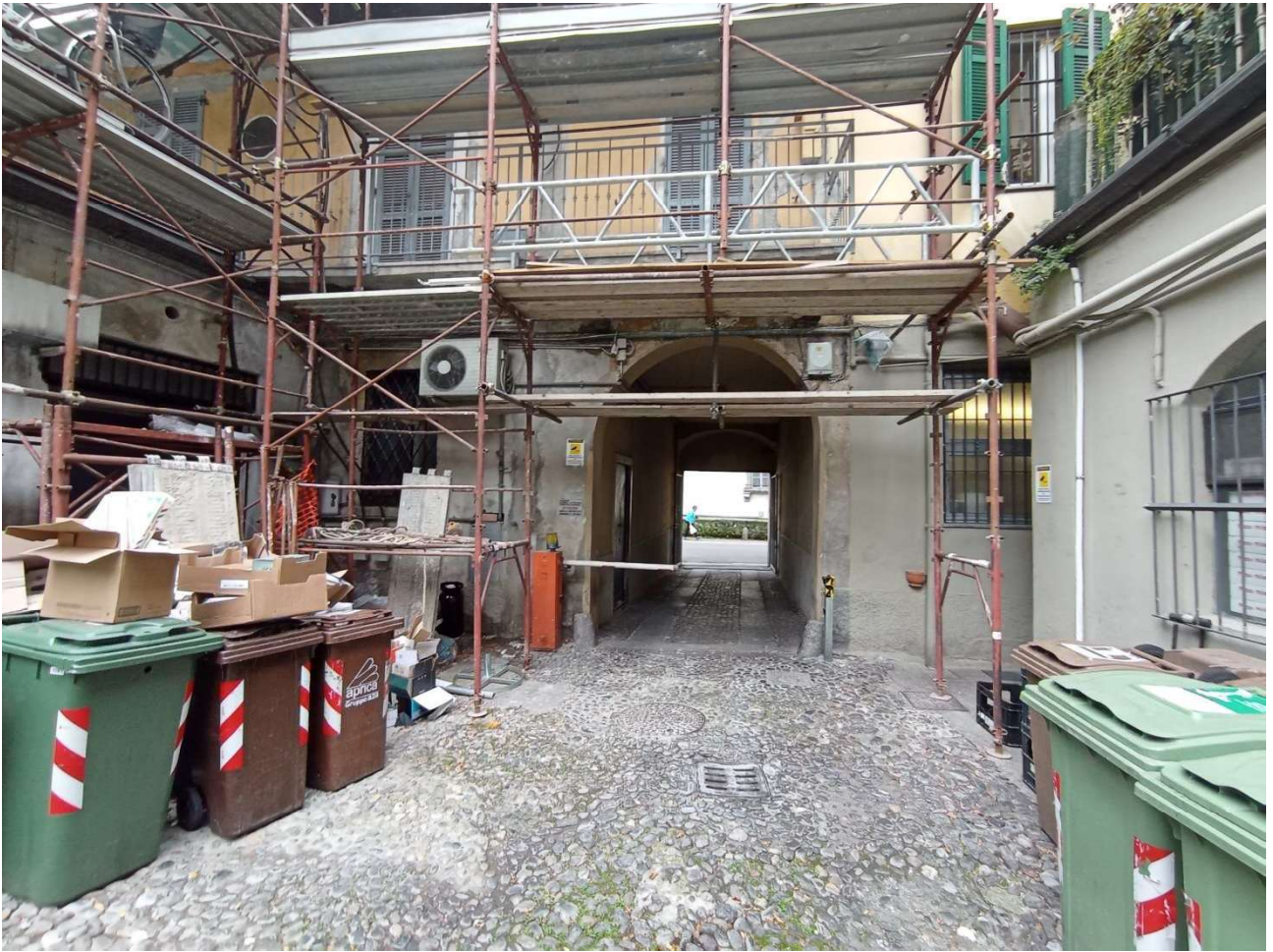
FOTO 9: CORTILE CONDOMINIALE INTERNO
