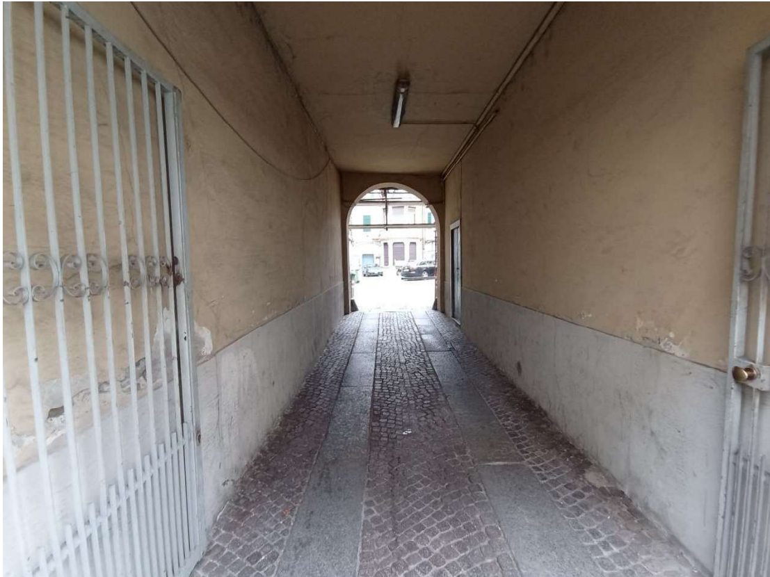
FOTO 8: CORSELLO CONDOMINIALE INTERNO CARRAIO
