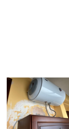
Veranda annessa alla cucina (senza infisso divisorio) Scaldabagno elettrico con vecchia infiltrazione di umidità
