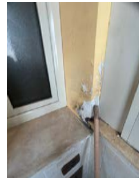
Infiltrazione di umidità dall'infisso veranda
