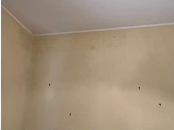
Particolare umidità da condensa parete camera da letto 1 e camera da letto 2
