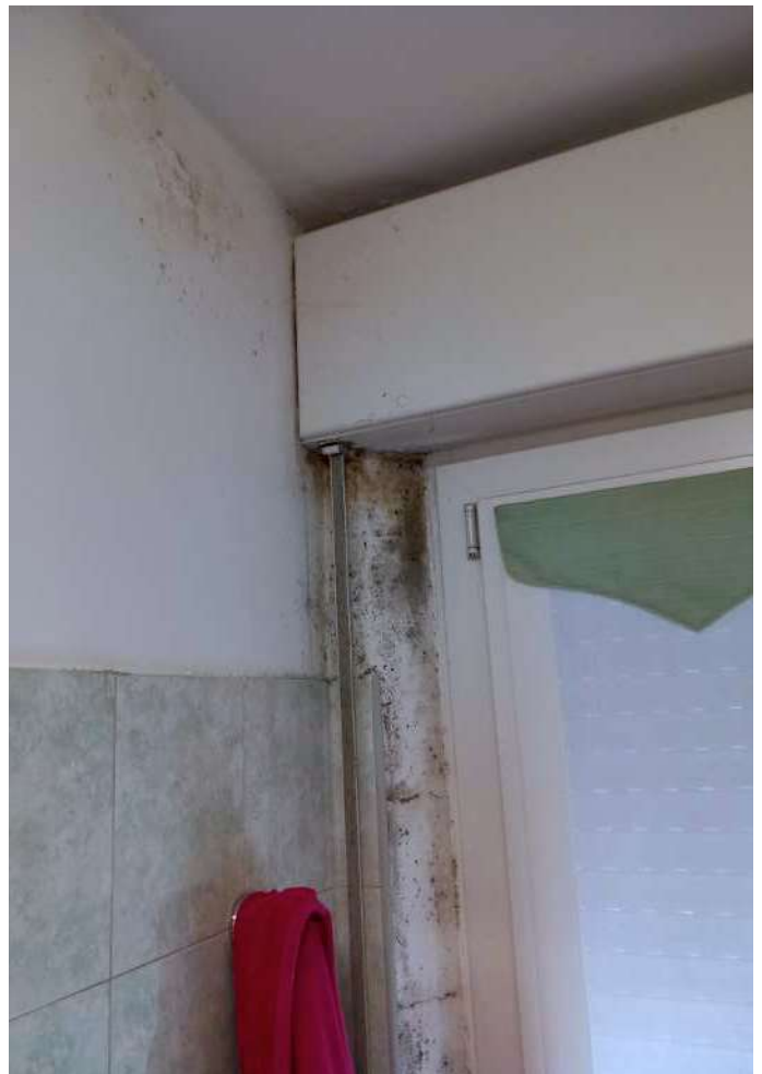
BAGNO PIANO PRIMO
