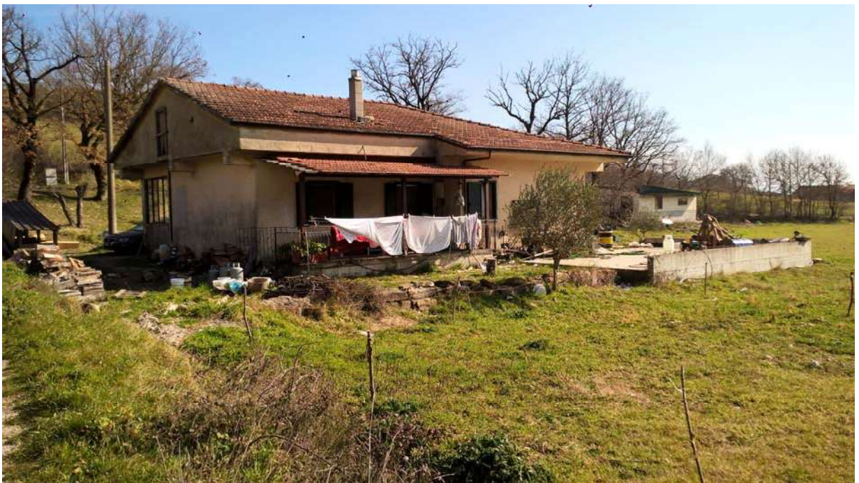
Foto n. 3 – prospetto nord ovest
