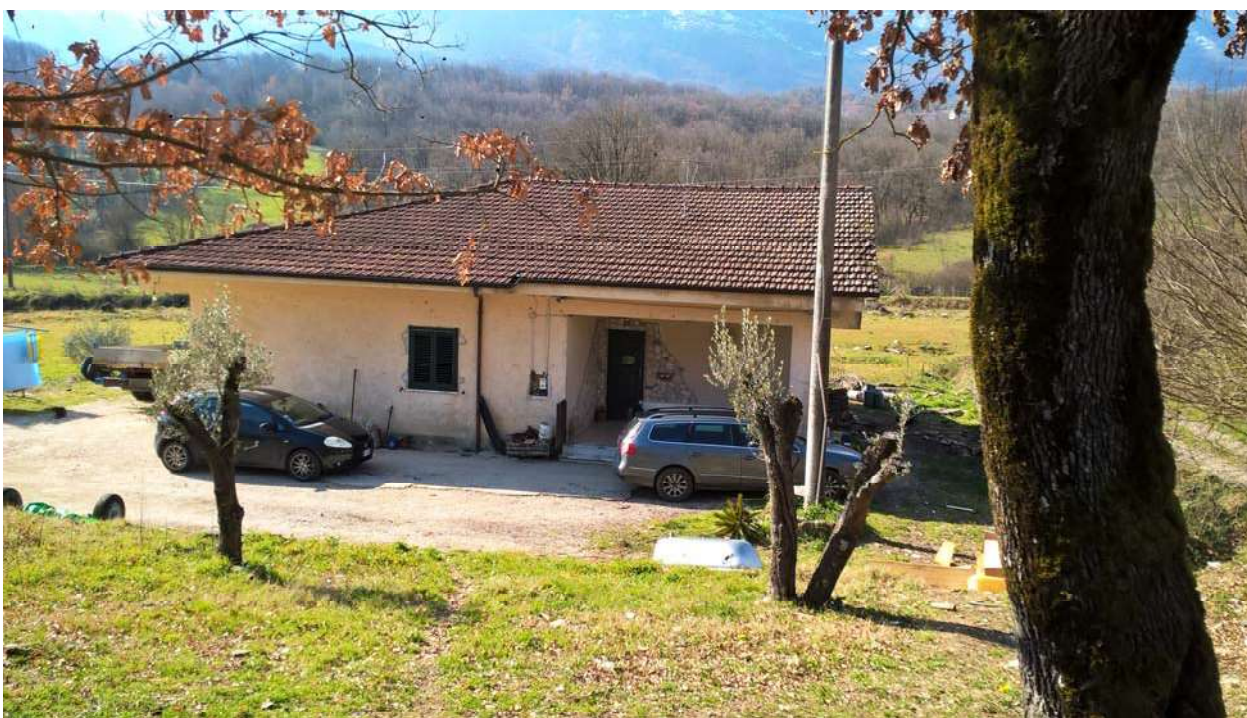
Foto n. 1 – prospetto su via Calaprece
