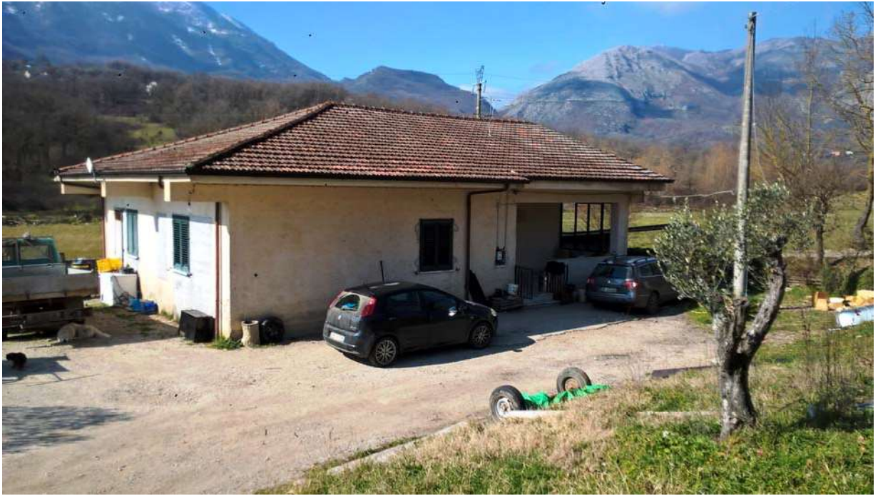
Foto n. 2 – prospetto sud est
