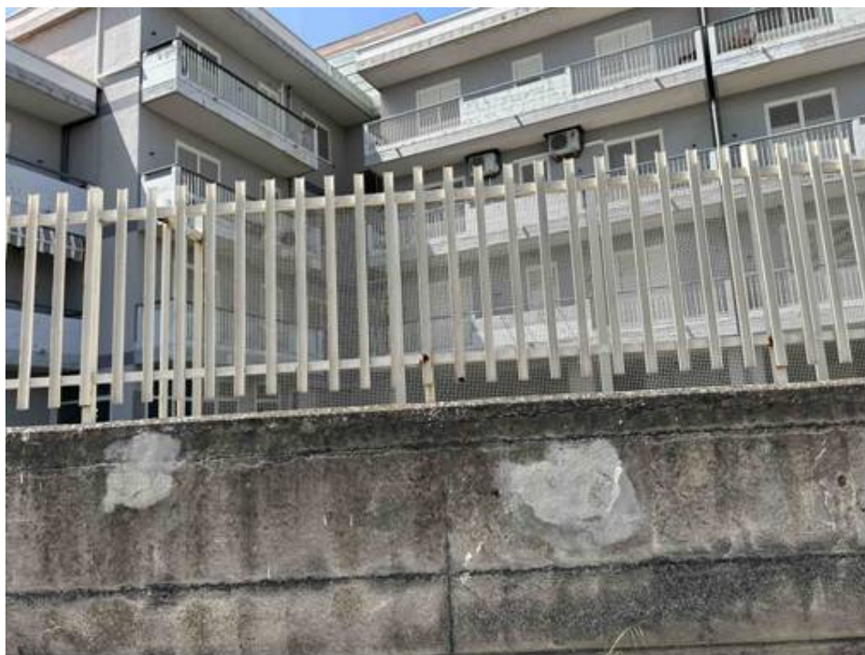
Foto n° 6 – Vista del muretto in cemento armato e della soprastante ringhiera.
