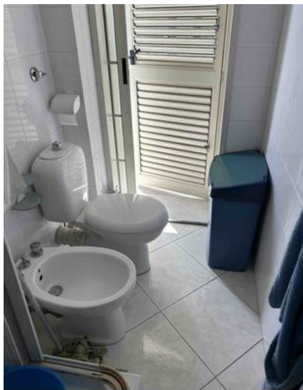
Foto n° 47 – Altra foto scattata all'interno del doppio servizio. Si rileva un piatto doccia con relativo box, un vaso igienico con cassetta incorporata ed un bidet. Sul fondo l'infixo in alluminio pre-verniciato.
