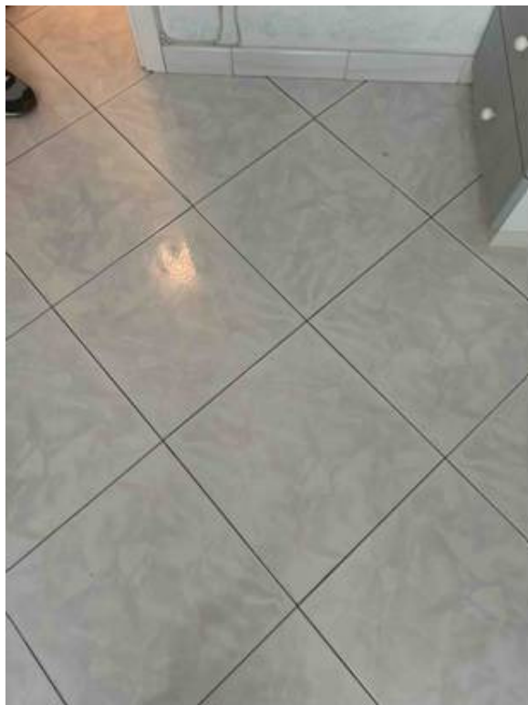
Foto n° 34 – Foto scattata alla pavimentazione in gres porcellanato. Ottime lo stato dell'immobile e le condizioni di manutenzione.
