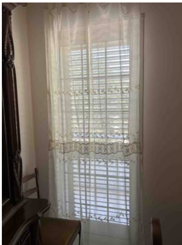
Foto n° 23 – Foto scattata all’infisso interno in alluminio pre-verniciato dello spessore di 4 cm. con vetrocamera. E’ inoltre presente un infisso esterno alla veneziana.
