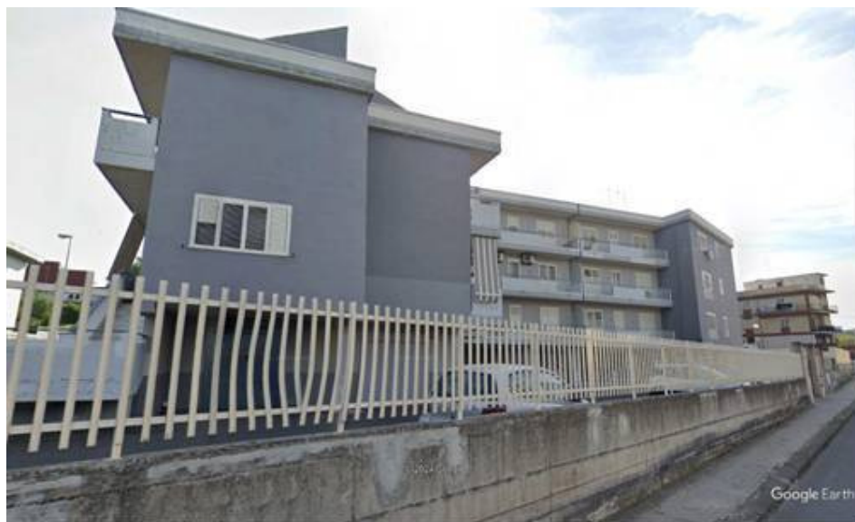
Foto n° 3 – Vista del prospetto principale su via Attard. L'edificio è costituito da quattro elevazioni fuori terra.
