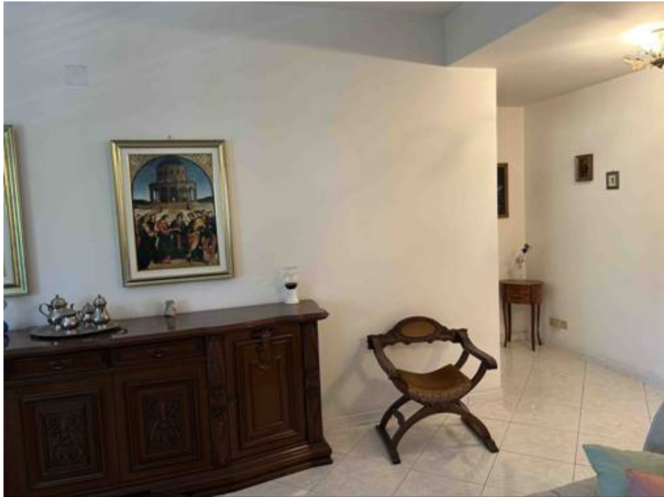
Foto n° 21 – Foto scattata all'interno dell'appartamento. La pavimentazione dell'ingresso/soggiorno è in gres porcellanato e le pareti sono tutte intonacate e tinteggiate con idropittura. Ottimo lo stato di manutenzione dell'immobile.
