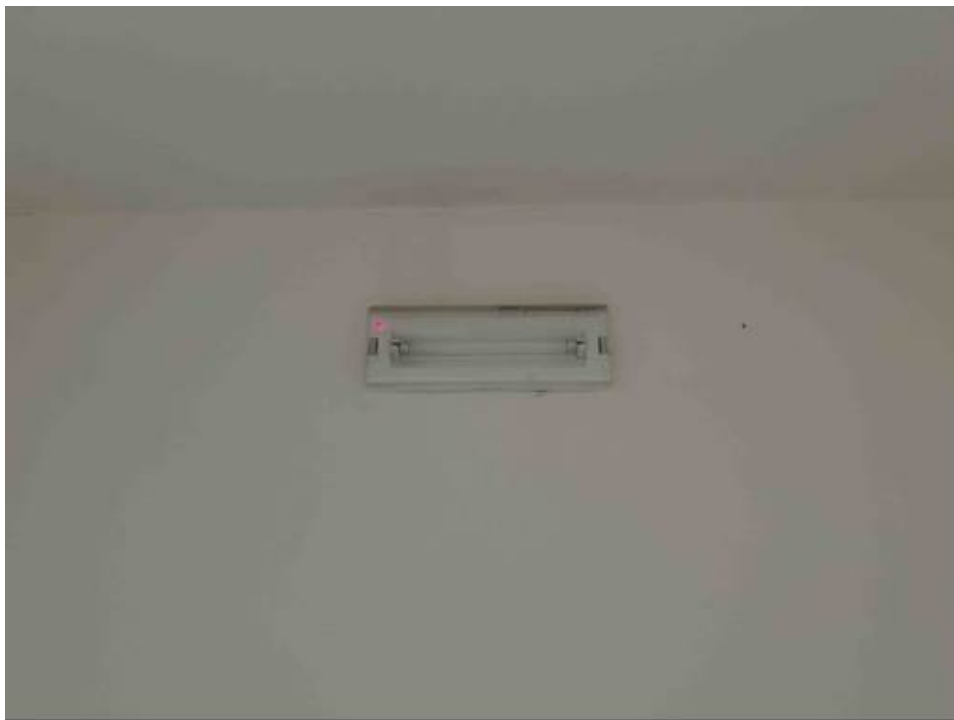
Foto n° 30 – Foto scattata alla luce di emergenza collocata nel vano soggiorno sopra la porta di ingresso.
