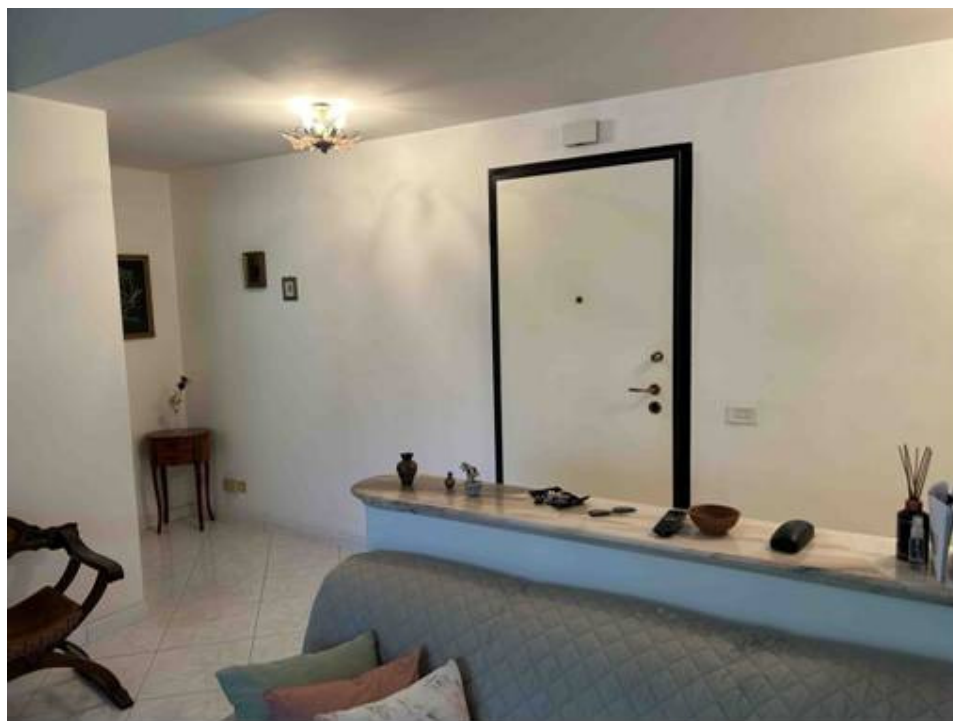
Foto n° 20 – Foto scattata all'interno dell'appartamento. La porta di ingresso è blindata mentre la pavimentazione è in gres porcellanato e le pareti sono tutte intonacate e tinteggiate con idropittura. Il vano è inoltre dotato di luce di emergenza.
