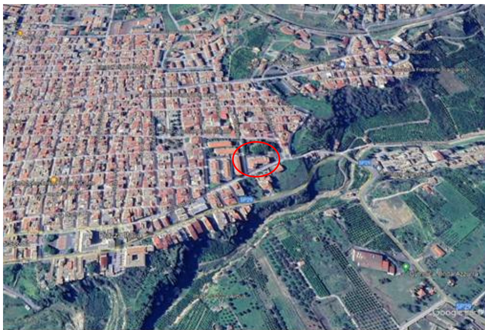
Foto n° 1 – Vista dall'alto di Google Earth. Col cerchio in rosso si è evidenziato il complesso residenziale in questione, situato in corrispondenza della via Attard a Scordia.
