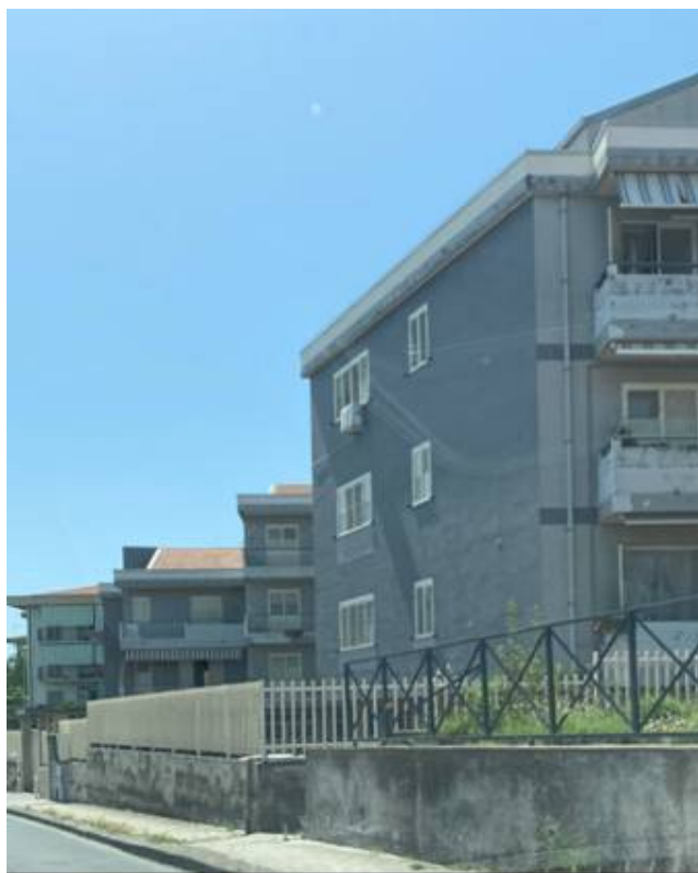
Foto n° 5 – Vista del prospetto principale su via Attard. L'edificio è costituito da quattro elevazioni fuori terra ed è delimitato da tutti i lati da un muretto in cemento armato e da una soprastante ringhiera.
