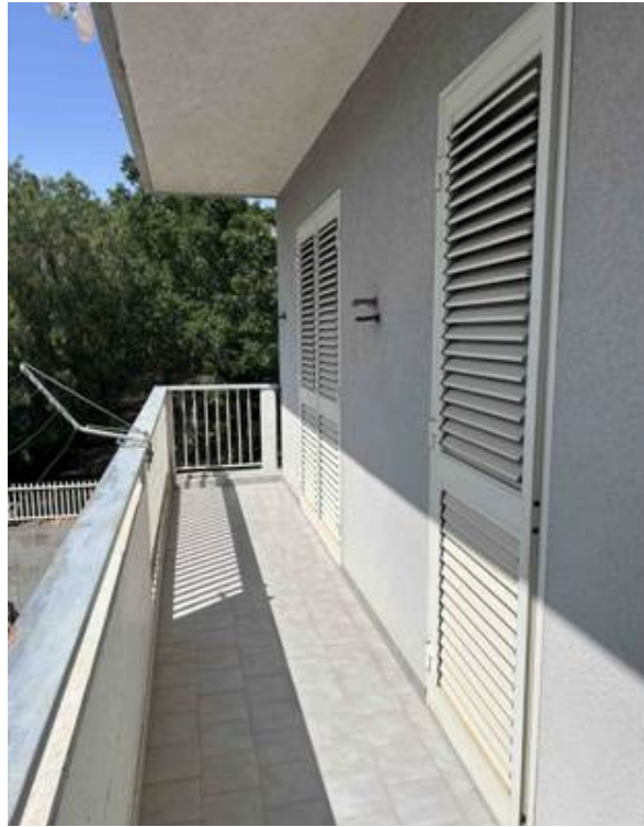
Foto n° 51 – Foto scattata nel ballatoio esposto a sud-ovest. La pavimentazione è in gres per esterni e la ringhiera è in alcuni tratti in ferro pieno ed in altri in calcestruzzo.
