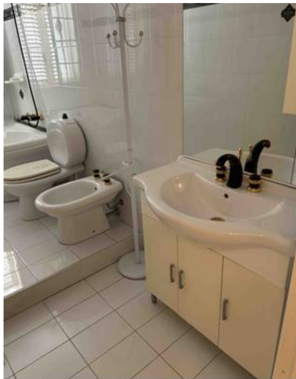
Foto n° 36 – Foto scattata all'interno del bagno. Lo stesso è pavimentato e rivestito con piastrelle rettangolari in pasta bianca fino all'altezza di 2,10 metri ed è corredato anche di greca decorativa intermedia di colore scuro.
