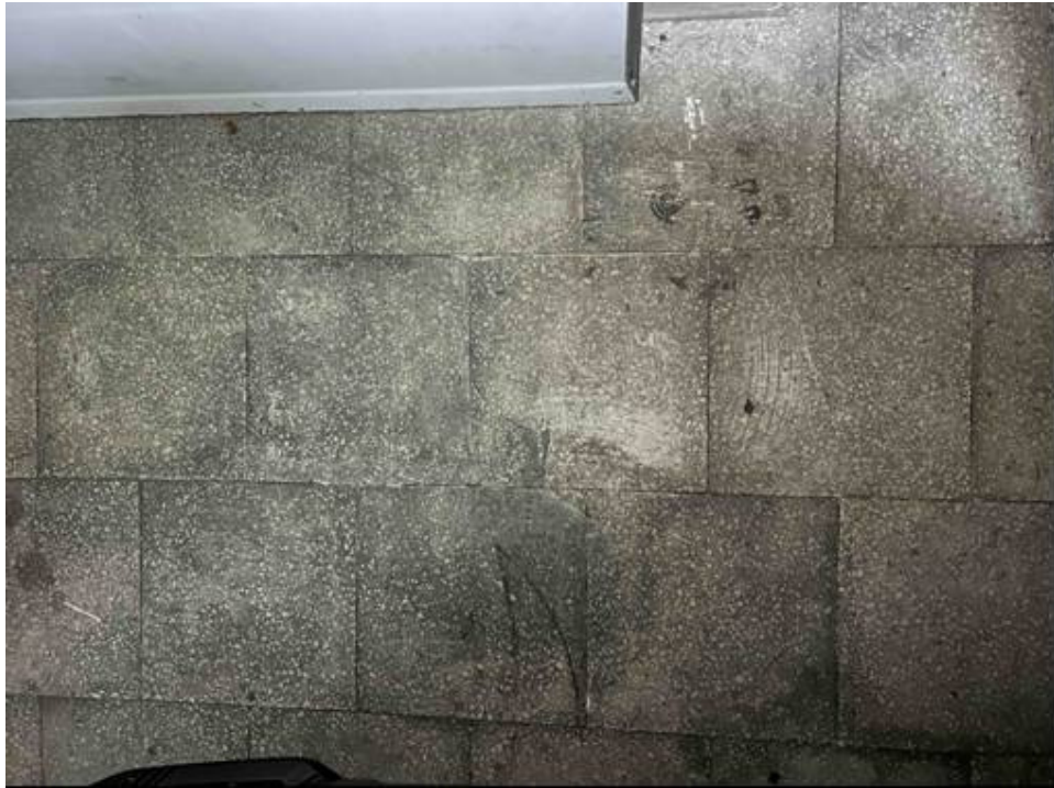
Foto n° 57 – Foto scattata alla pavimentazione in scaglietta di marmo.
