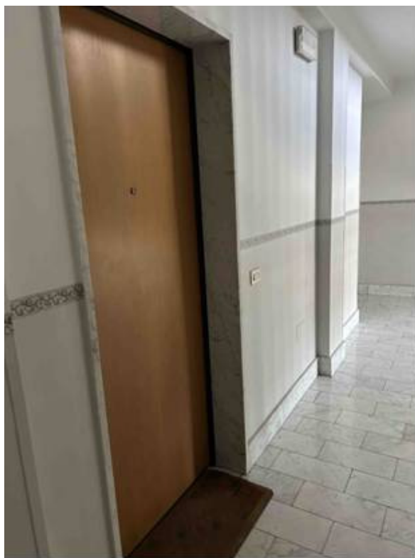
Foto n° 19 – Foto scattata alla porta di ingresso all'appartamento.
