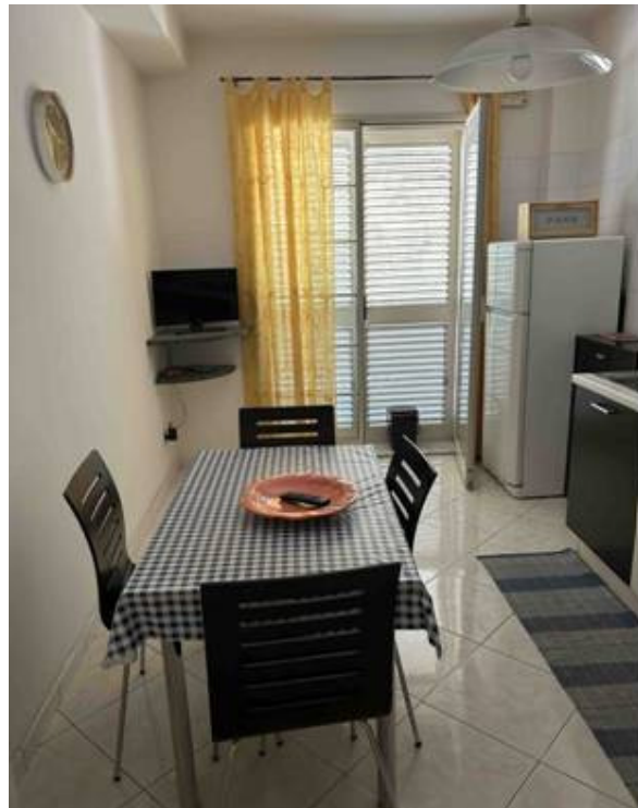
Foto n° 26 – Foto scattata al pavimento in gres porcellanato e all'infisso preverniciato. Le pareti sono tutte intonacate e tinteggiate con idropittura. Ottime le condizioni.
