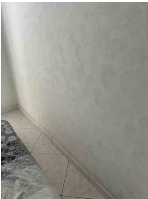
Foto n° 33 – Foto scattata all'interno di una cameretta. Le pareti sono tutte intonacate e tinteggiate con la tecnica dello spatolato. Ottime le condizioni.
