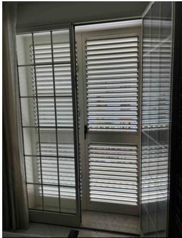
Foto n° 40 – Foto scattata all'interno di una camera da letto. E' presente l'infisso in alluminio pre-verniciato dello spessore di 4 cm dotato di vetrocamera e ed è visibile l'infisso esterno alla veneziana.
