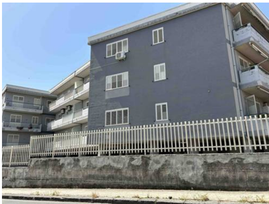
Foto n° 4 – Vista del prospetto principale su via Attard. L'edificio è costituito da quattro elevazioni fuori terra.
