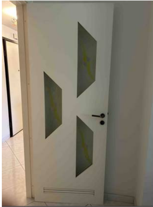
Foto n° 25 – Foto scattata alla porta interna in legno dotata di inserti in vetro che consente l'accesso al vano cucina. Ottime le condizioni e/o lo stato di manutenzione.
