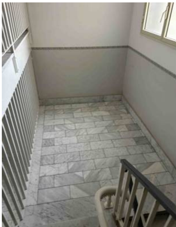
Foto n° 17 – Altra foto al pianerottolo intermedio. La pavimentazione è in marmo bianco mentre le pareti sono intonacate e tinteggiate con idropittura.
