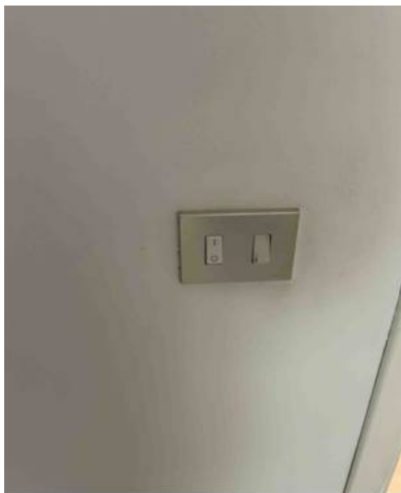
Foto n° 27 – Foto scattata all'interruttore posto nel vano cucina. Buone le condizioni dell'impianto elettrico sottotraccia.
