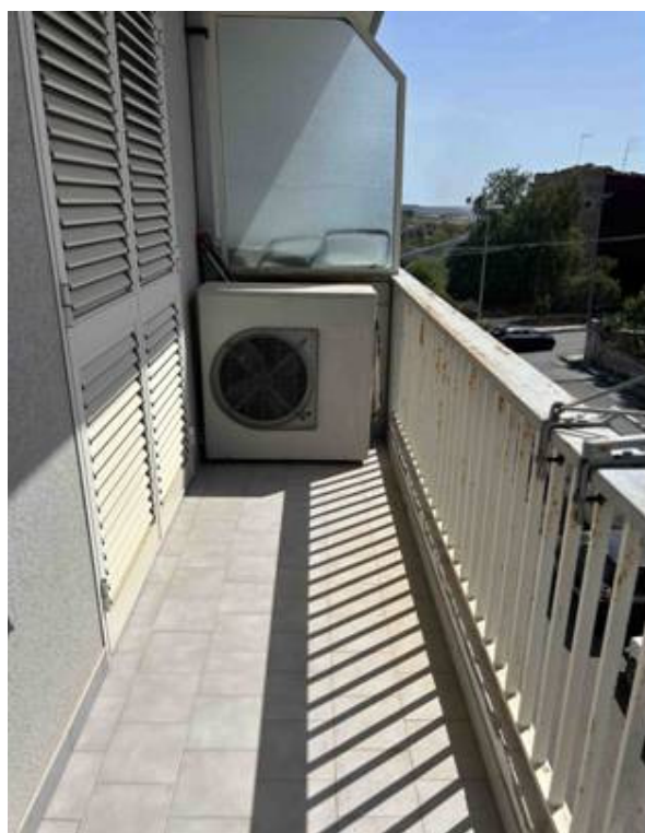
Foto n° 48 – Foto scattata nel ballatoio esposto a sud-est. La pavimentazione è in gres per esterni e la ringhiera è in ferro pieno. Sul fondo è collocata una parete divisoria in bachelite e vetro che separa questo ballatoio da quello dell'appartamento confinante.
