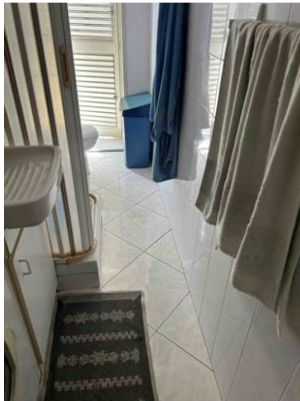
Foto n° 44 – Foto scattata all’interno del doppio servizio. La pavimentazione è in gres porcellanato mentre le pareti sono rivestite con piastrelle in pasta bianca. Si rileva una pilozza dotata di mobile ed un piatto doccia con relativo box.
