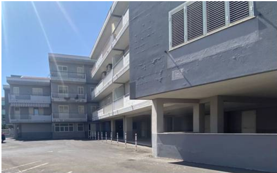
Foto n° 8 – Vista del cortile interno principale da cui si può accedere sia ai portoni delle scale condominiali sia ai garages/box posti nel retro prospetto. La pavimentazione del cortile interno è in conglomerato bituminoso.
