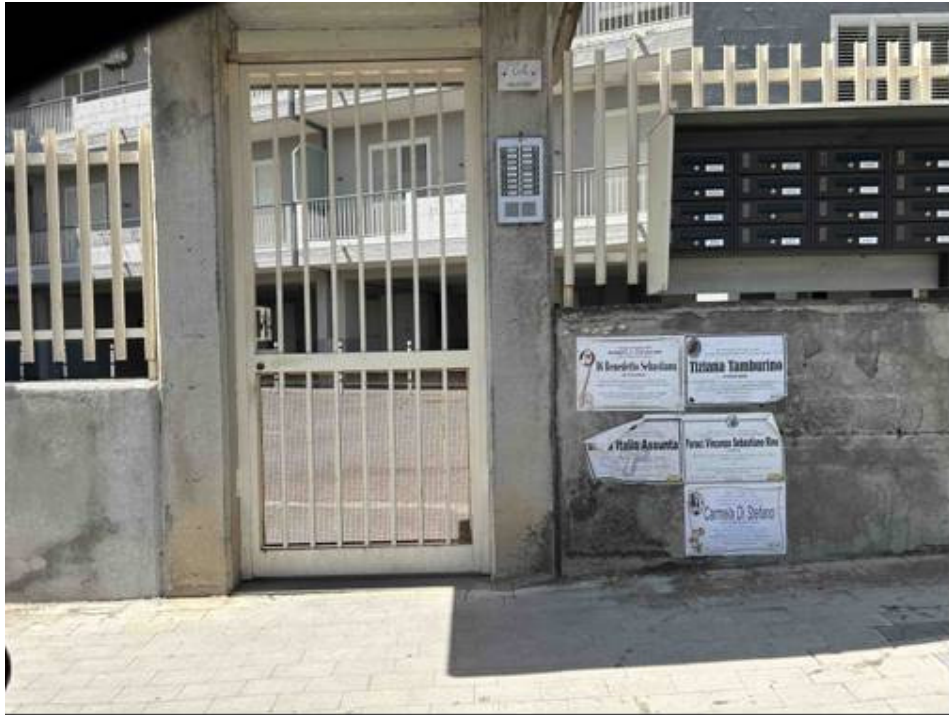
Foto n° 7 – Vista del cancello di ingresso pedonale. A sinistra è anche presente un cancello scorrevole (azionabile anche con comando a distanza) che consente l'ingresso delle auto dei condomini.
