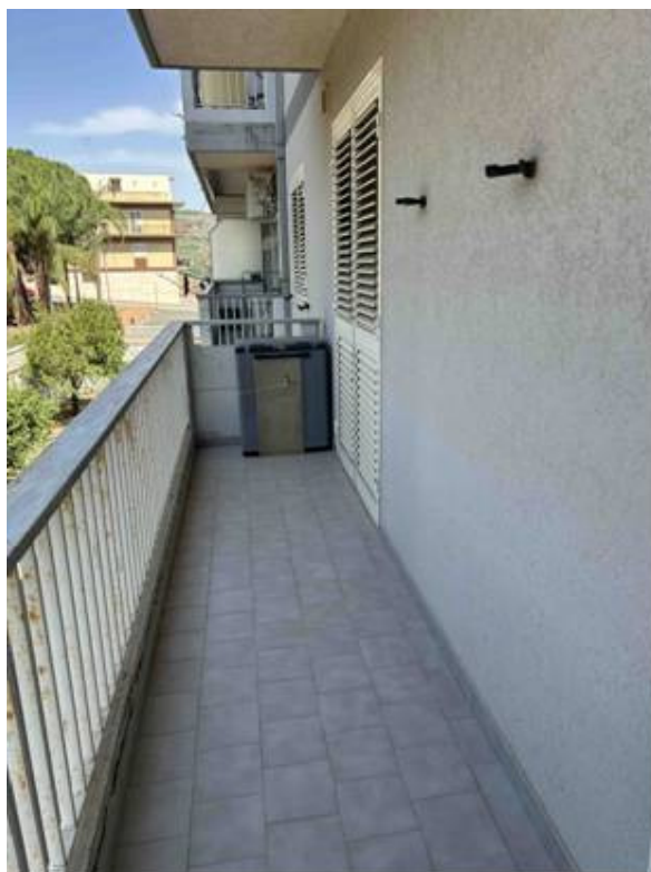
Foto n° 53 – Altra foto scattata nel ballatoio esposto a sud-ovest. La pavimentazione è in gres per esterni e la ringhiera è in ferro pieno.
